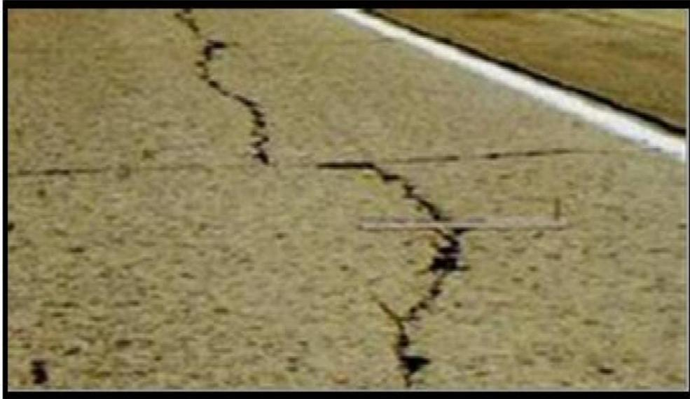
**Grafico N° 1. Fisura longitudinal – Fuente: Tipos de Deterioro en Pavimentos Rígidos – ARGOS**
