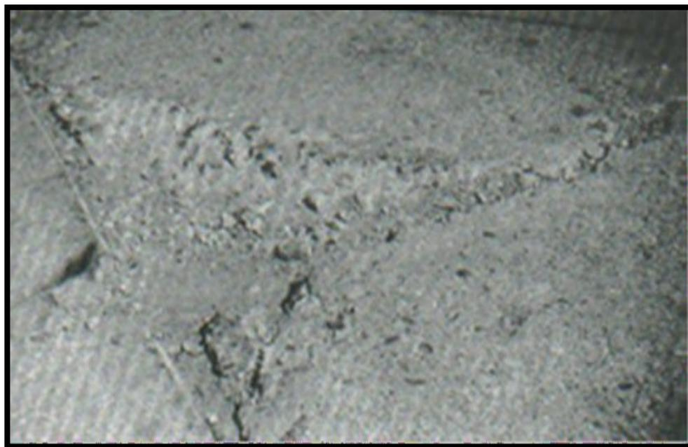
**Grafico N° 2: fisura de esquina – Fuente: Tipos de Deterioro en Pavimentos Rígidos – ARGOS**
