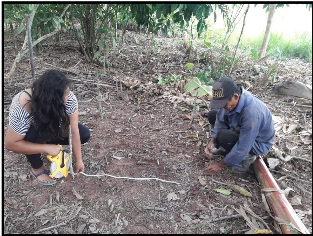
Figura 30: Trazo para la elaboración de calicatas.. Fuente: Elaboración propia
