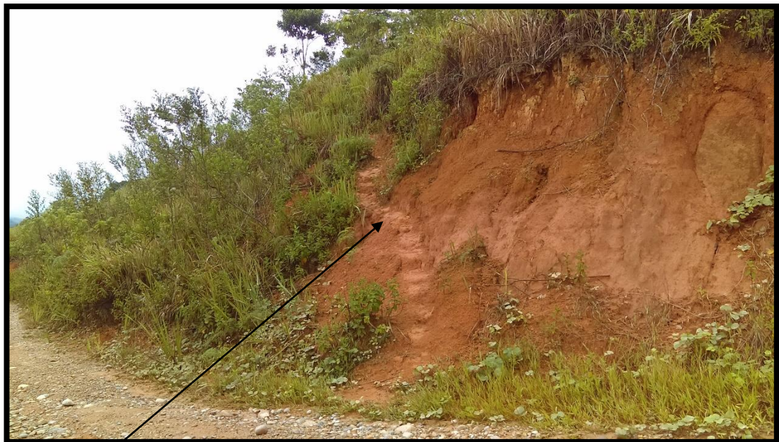
Figura 28: Camino de entrada a donde será nuestro reservorio
