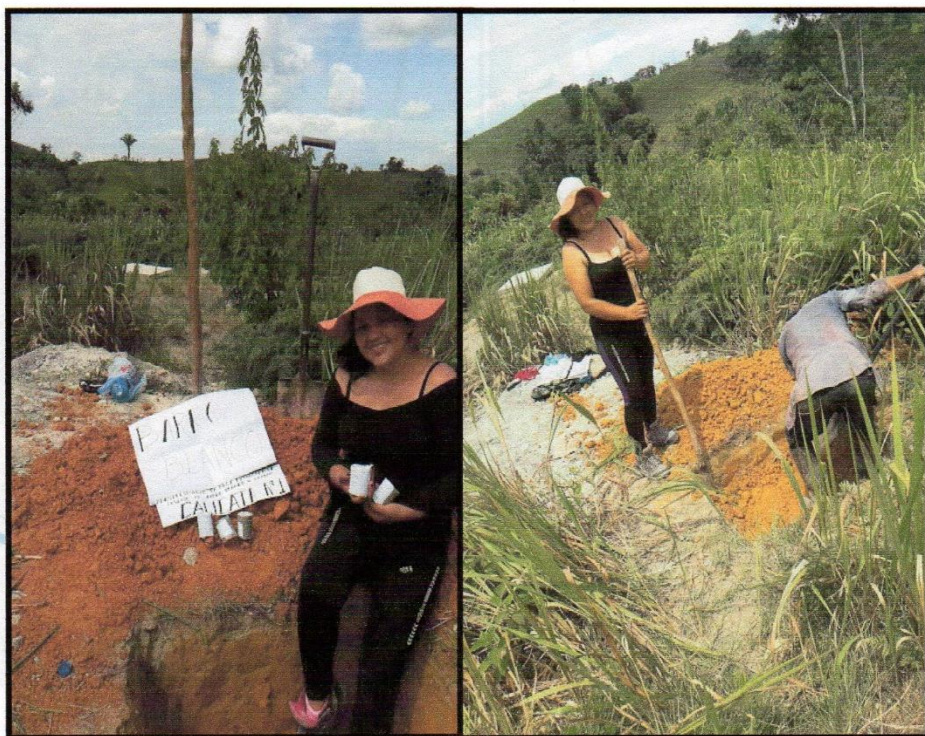
Fotografía N° 02: ESCAVACION CALICATA C-2
