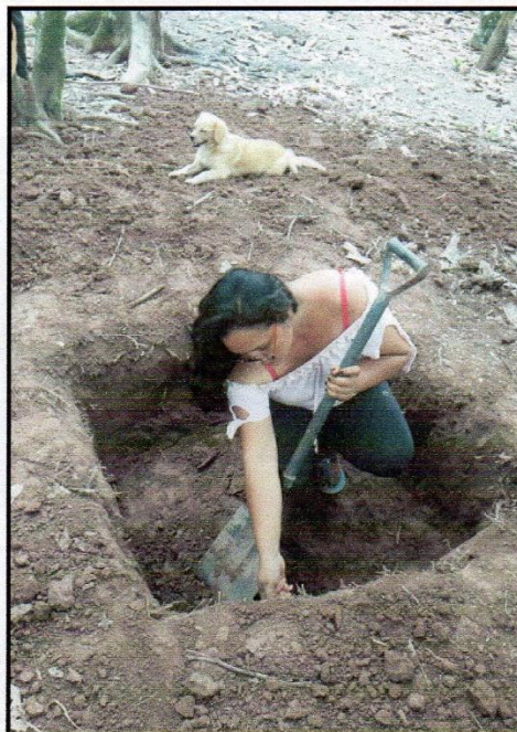
Fotografía N° 05: ESCAVACION CALICATA C-5
