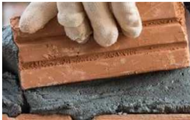
Gráfico 3: Mortero aplicado en muro de albañilería.
