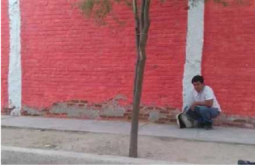
Gráfico 56: Presencia de erosión en el paño comprendido entre los ejes 6 y 7 .
