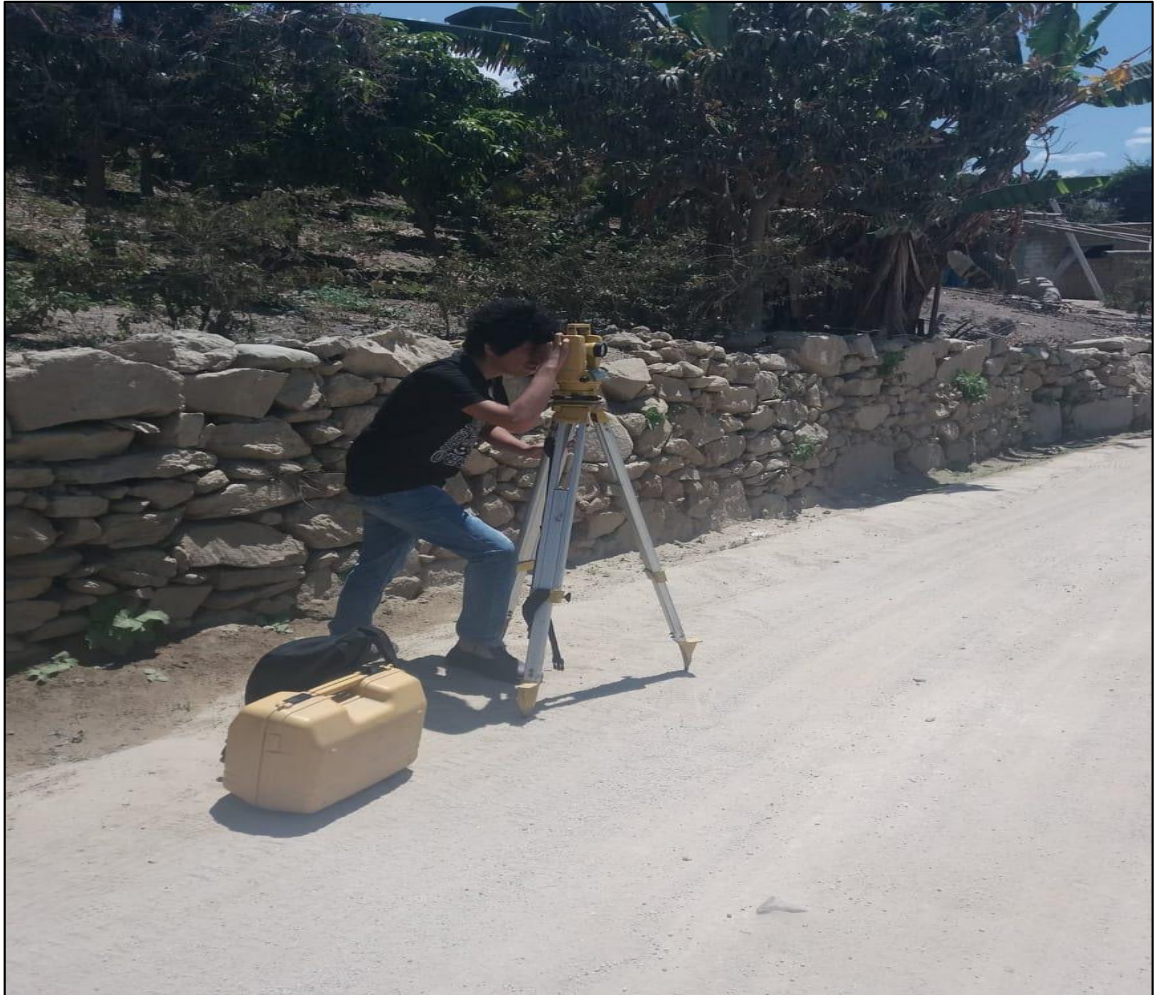
Fotografía 05: Realizando el levantamiento topográfico (2019).
