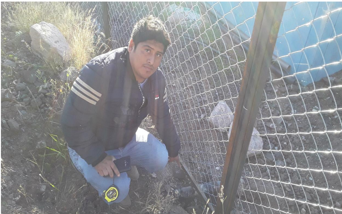
Figura 38: Ingreso de la línea de conducción hacia el reservorio.
