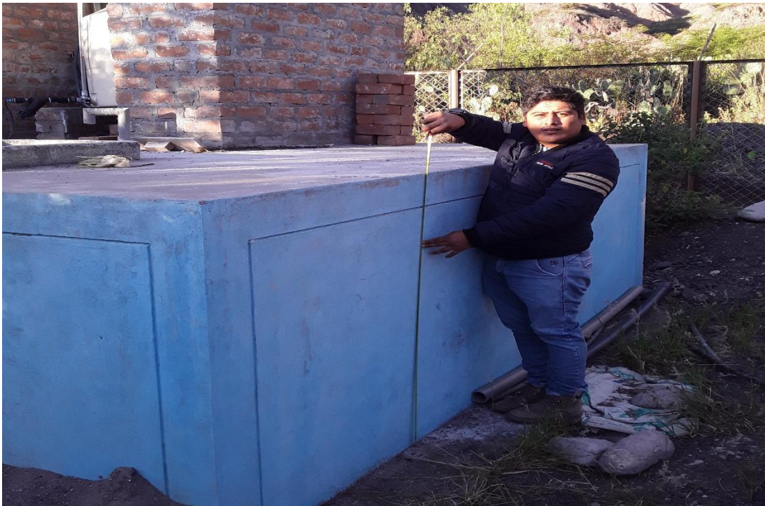
Figura 36: Reservorio- capacidad de 16 m 3
