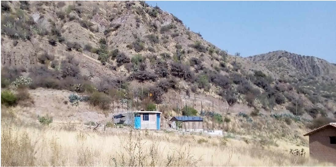
Figura 39: Inspección de la línea de distribución.
