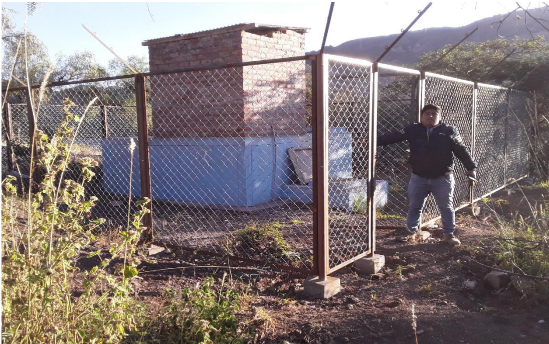
Figura 18: Reservorio de capacidad 16m 3
