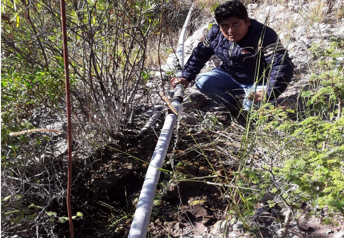
Figura 35: Línea de conducción F° G° diámetro de 2"
