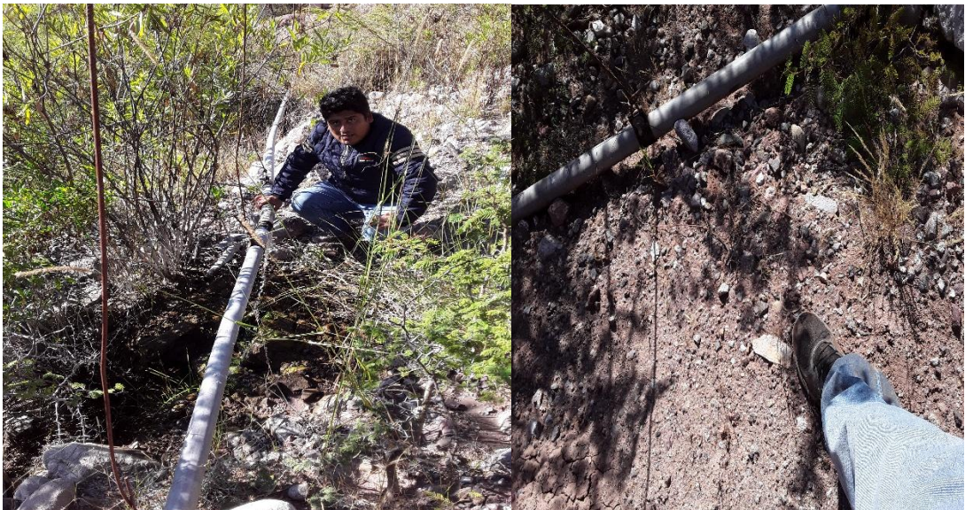
Figura 15: Línea de conducción con tubo galvanizado-uniones.
