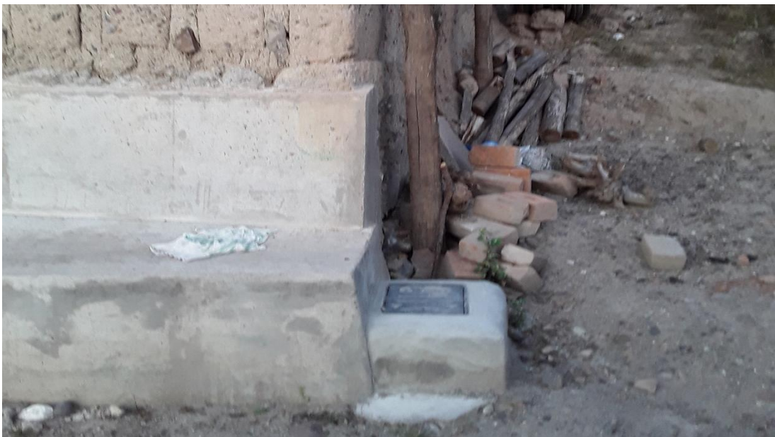
Figura 22: Caja-conexión domiciliaria
