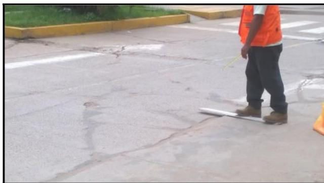
**Figura 18:** Escala de nivel de severidad alta.
