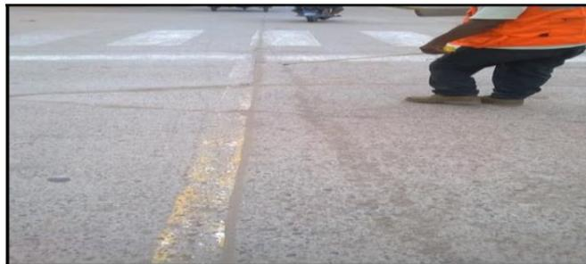
*Figura 13:* Pulimento de agregados.
