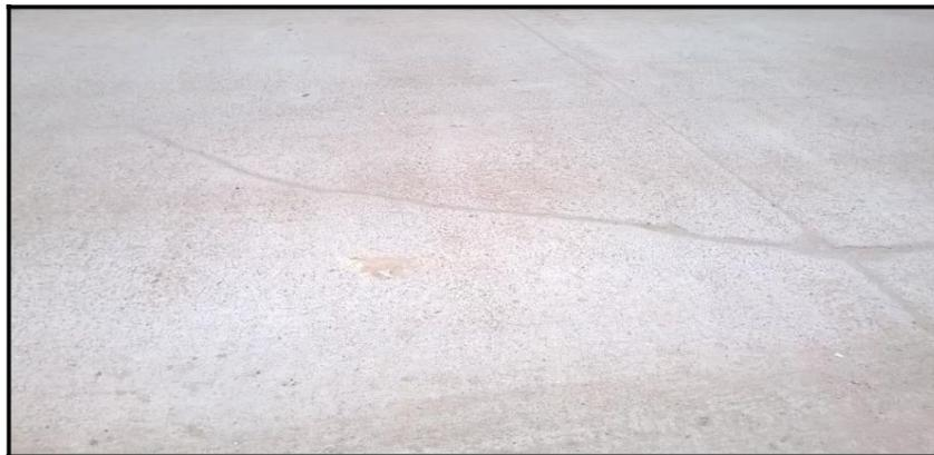
*Figura 09:* Grieta de esquina de nivel de severidad media.
