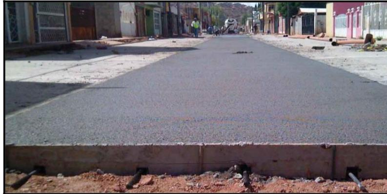
*Figura 12:* Construcción de losa con refuerzo.
