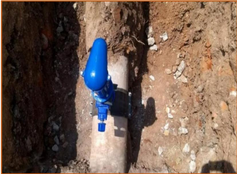
*Imagen 10:* Válvula de aire automático.
