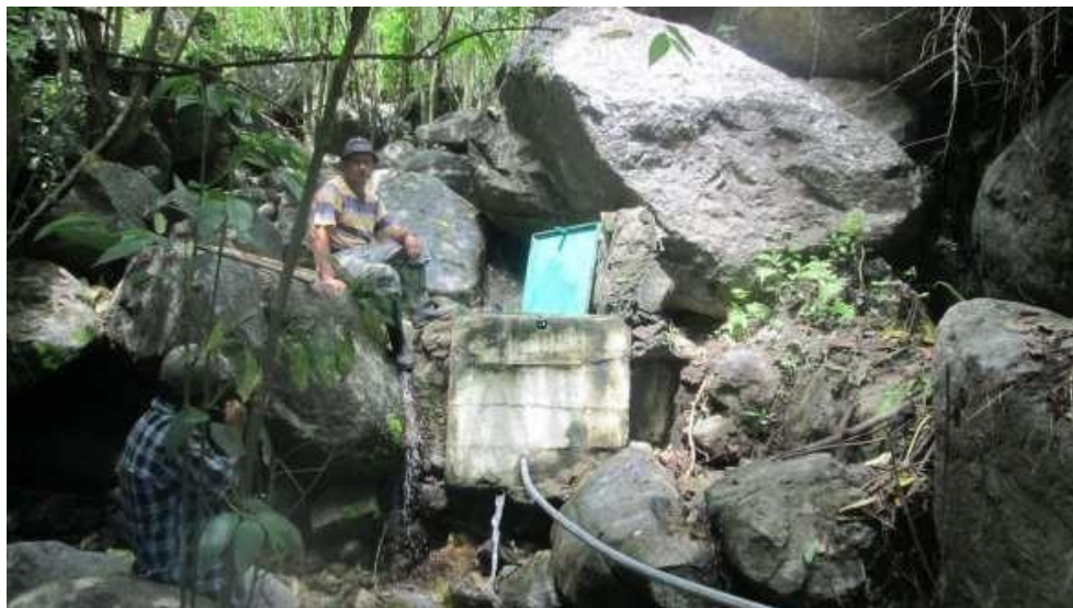
ILUSTRACIÓN 3: CAPTACIÓN QUEBRADA “LA CUEVA”
