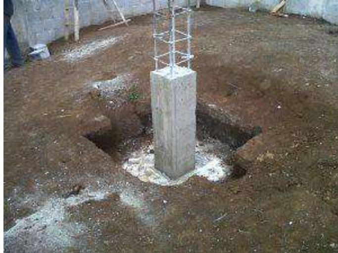
Gráfico: 6 Columna de concreto Fuente: ARQHYS, 2013 6
