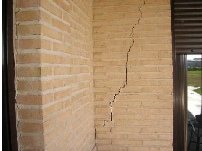
Gráfico: 10 Fisura en el muro de albañilería Fuentes: fisura.es 9
