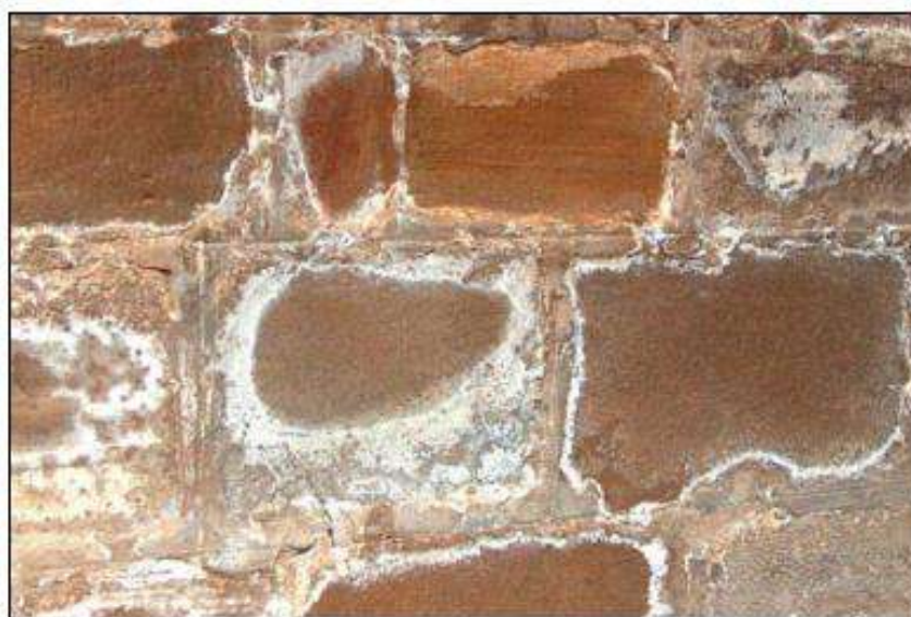
Gráfico: 12 Eflorescencia en el muro Fuente: Universidad de Chile 11
