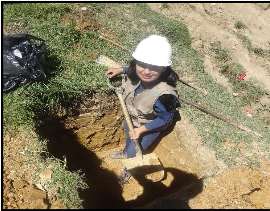
Figura 14: Excavación de calicata en la línea de conducción.
