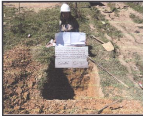
Foto N° 04.- En la toma se aprecia la excavación de la calicata C-04.
