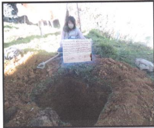
Foto N° 07.- En la toma se aprecia la excavación de la calicata C-07
