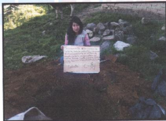
Foto N° 08.- En la toma se aprecia la excavación de la calicata C-08
