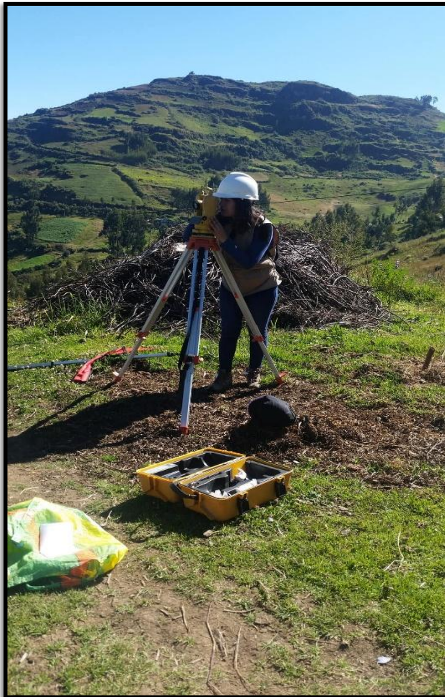
Figura 12: Levantamiento topográfico con estación total.
