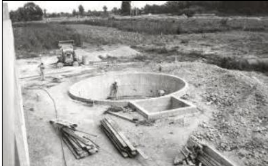
Figura 16: Reservorio enterrado
