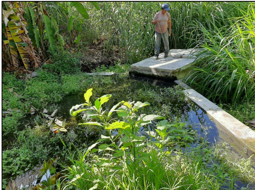
Figura 09: Captación de ladera
