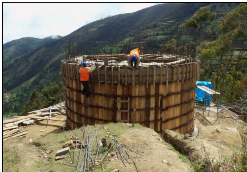
Figura 14: Reservorio apoyado de forma circular
