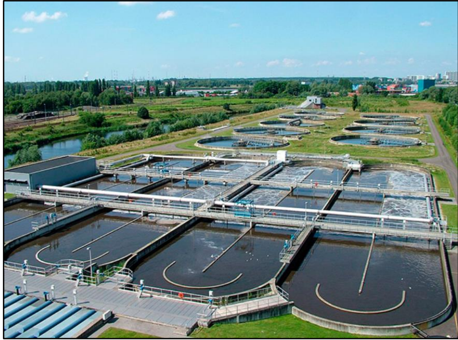
Figura 05: Tratamiento de agua
