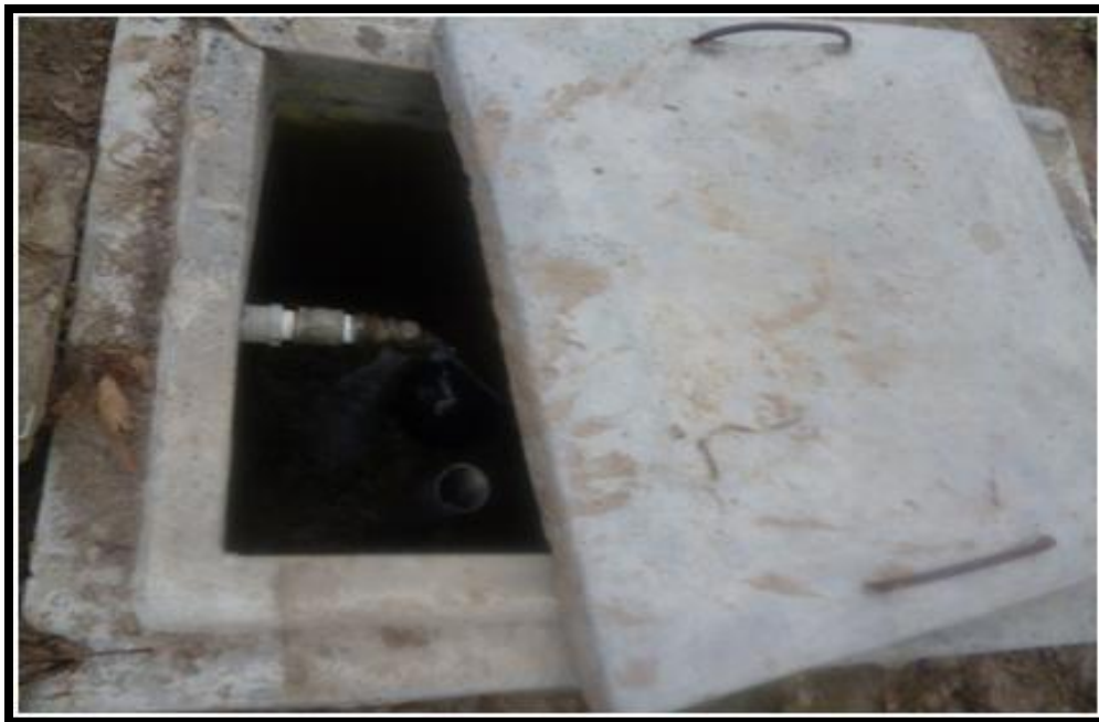
CRP en mal estado, como se puede observar, esta es una de las CRP que podemos observar, a su vez su cantidad es muy reducida para las presiones que contempla el sistema.
