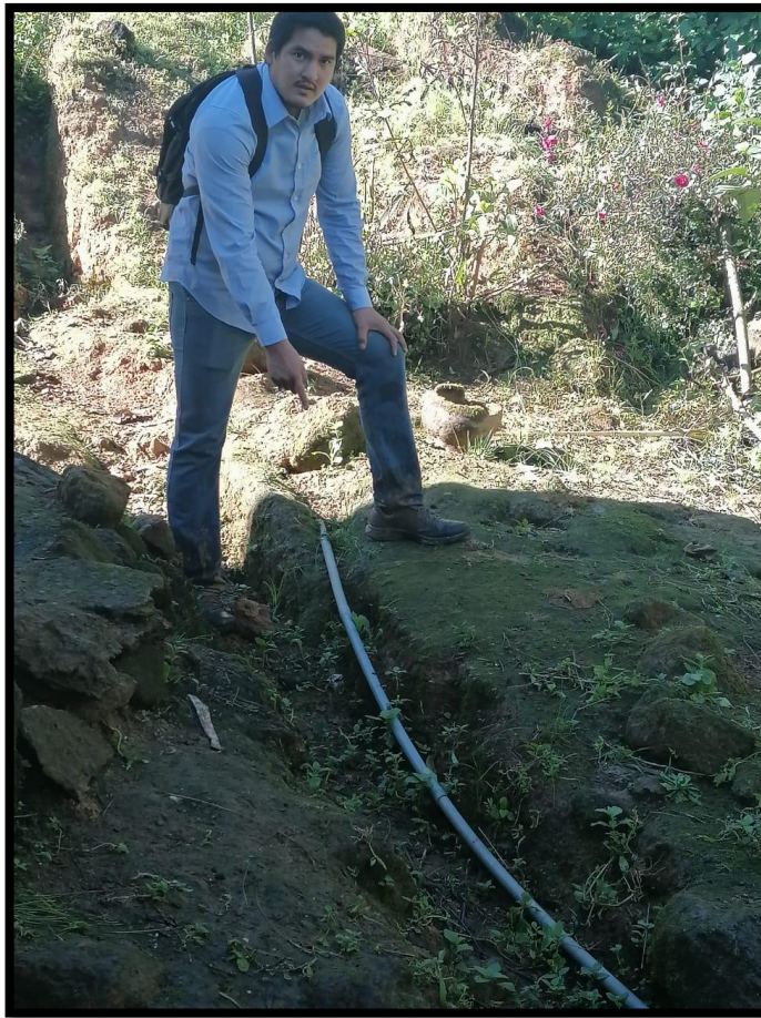
Línea de distribución de 1" a la intemperie e instalada de manera artesanal por los mismos pobladores.
