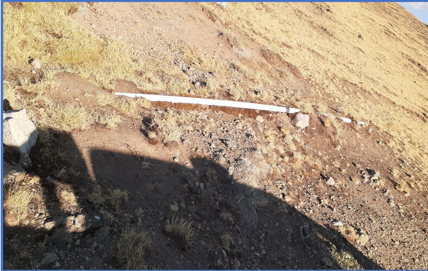
Imagen 2. Línea de conducción tramo 1
