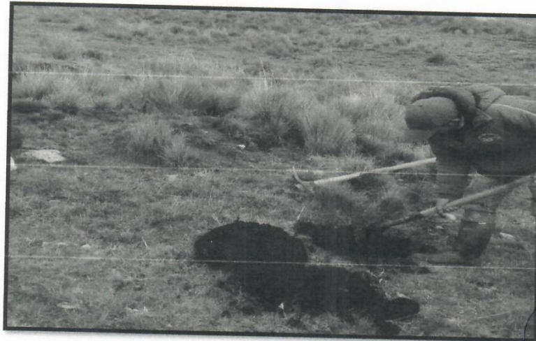
IMAGEN VISTA DE LA CALICATA N°1-A
