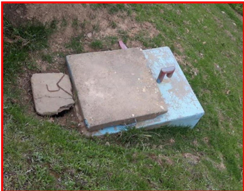
Imagen 11. Estructura de la cámara rompe presión tipo 6
