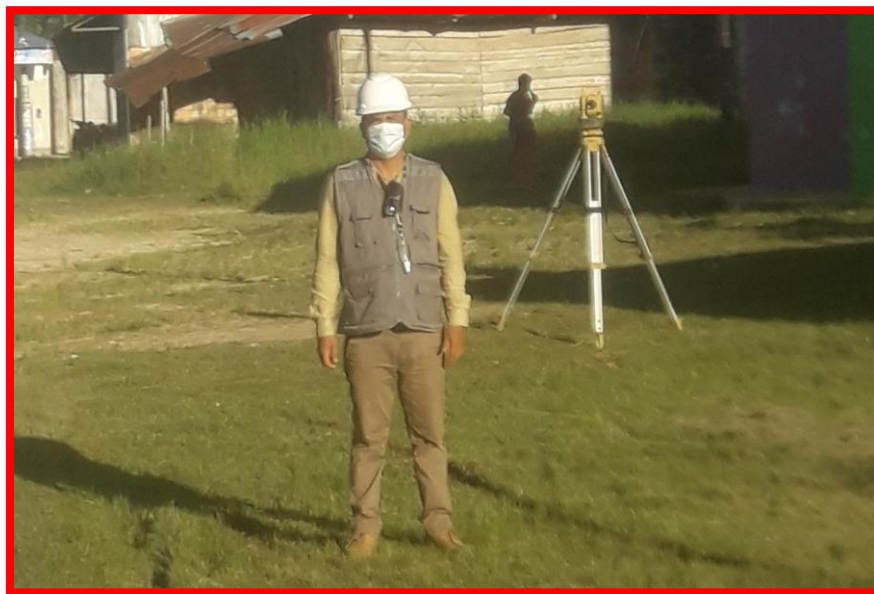
Imagen 19. Levantamiento topográfico en la red de distribución del caserío Hurgopata
