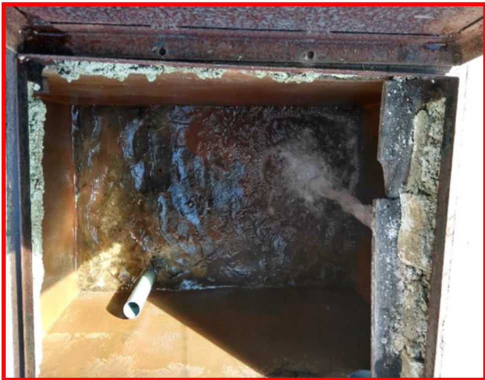
Imagen 02. Cámara húmeda de la captación
