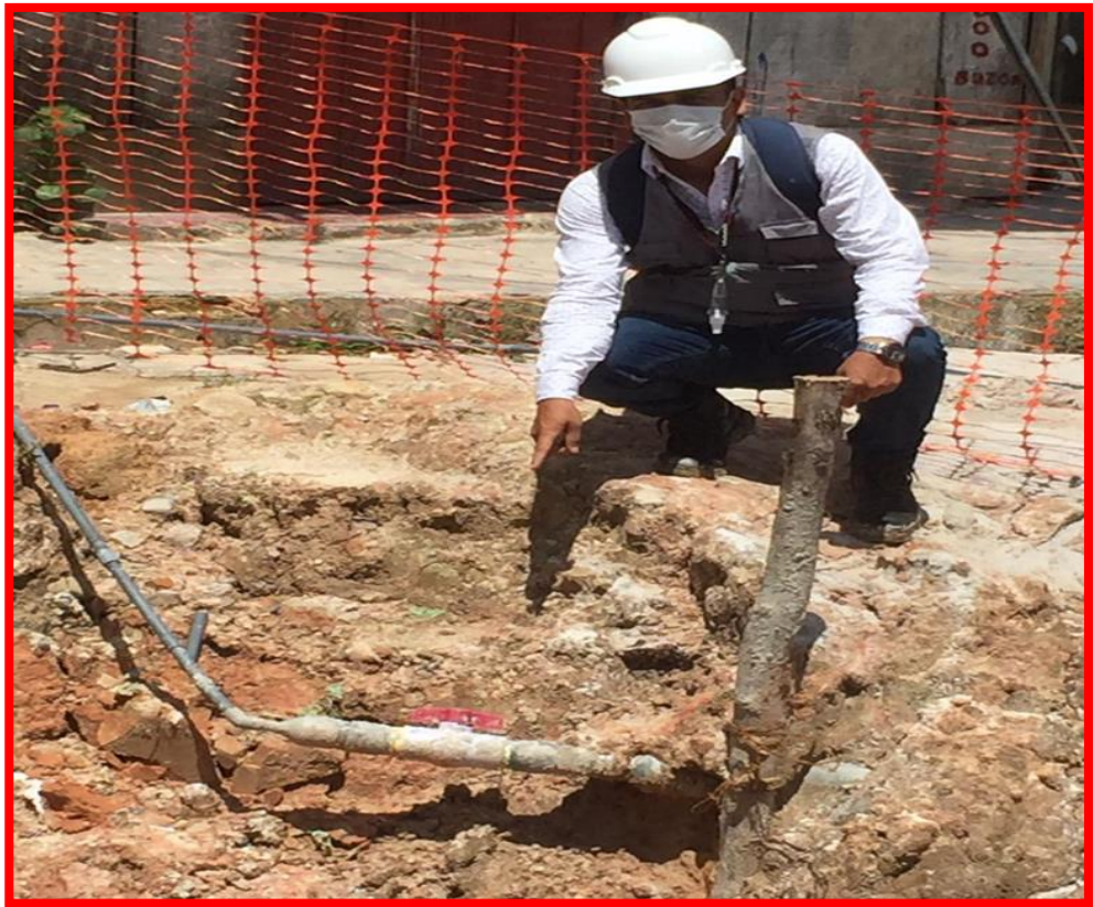
Imagen 08. Red de distribución expuesta a la intemperie (tubería principal)
