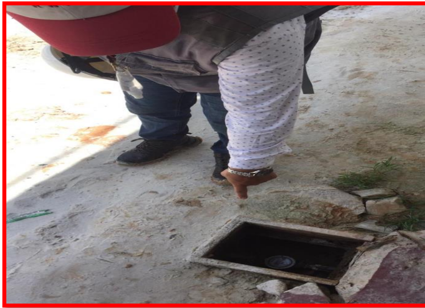
Imagen 16. Conexión entre la red de distribución y la conexión domiciliaria existente.
