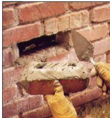
**Fig. 5.19** Colocación de nuevo ladrillo (Black & Decker 2000)
