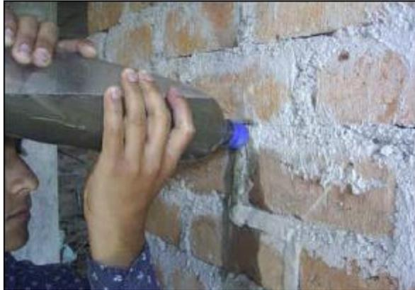
**Fig. 5.12** Inyección de grietas con lechada de cemento. (Mosqueira ,Tarque .2005).
