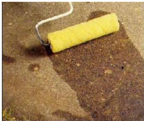
**Fig. 5.03:** Aplicación de solución limpiadora (Black & Decker 2000)
