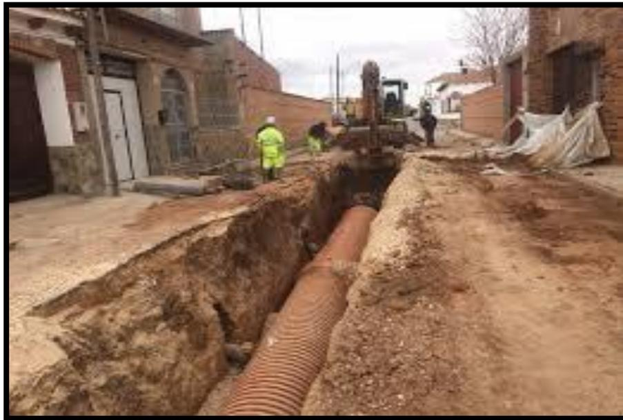
Gráfico N° 2: Colector General de un sistema de alcantarillado
