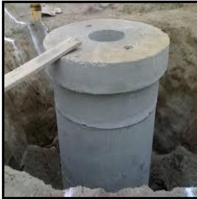
Gráfico N° 3: Buzón tipo I instalado en obra (de altura menor a 3.00m)
