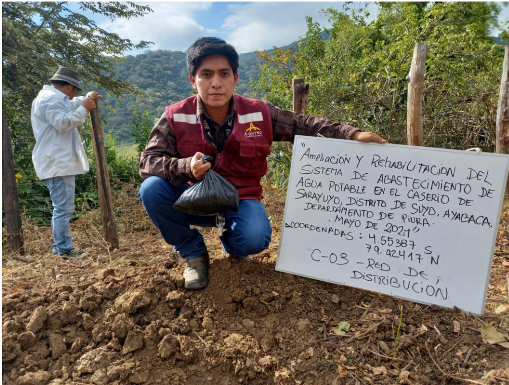
FOTO N°3: CALICATA – RED DE DISTRIBUCION
