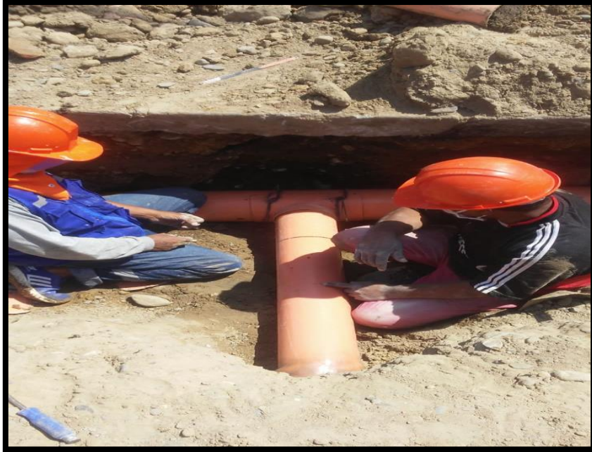
Figura 2: Tuberías laterales Fuente: Elaboración Propia.
