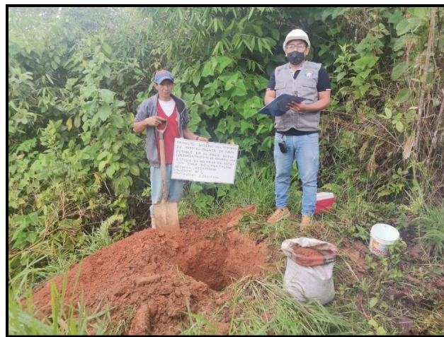
Figura 27: Excavación con el encargado del anexo nueva esperanza Fuente: Elaboración propia
