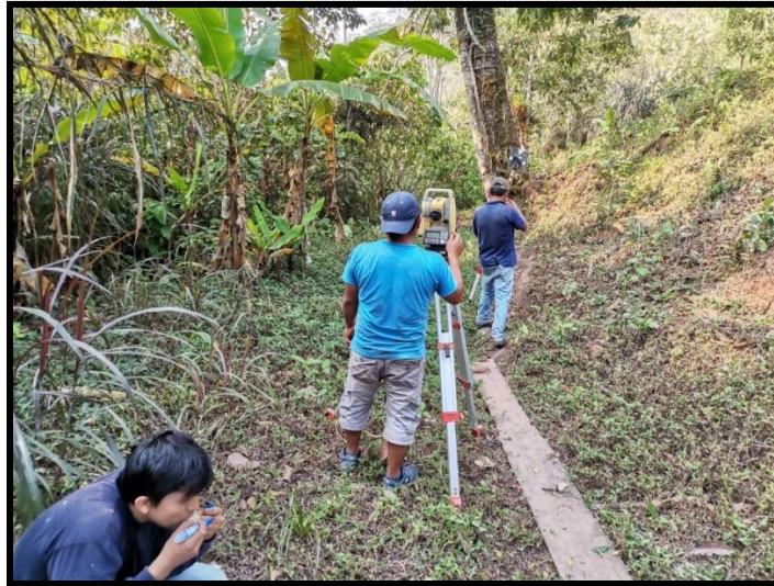
Figura 32: Levantamiento tramo línea de aducción
