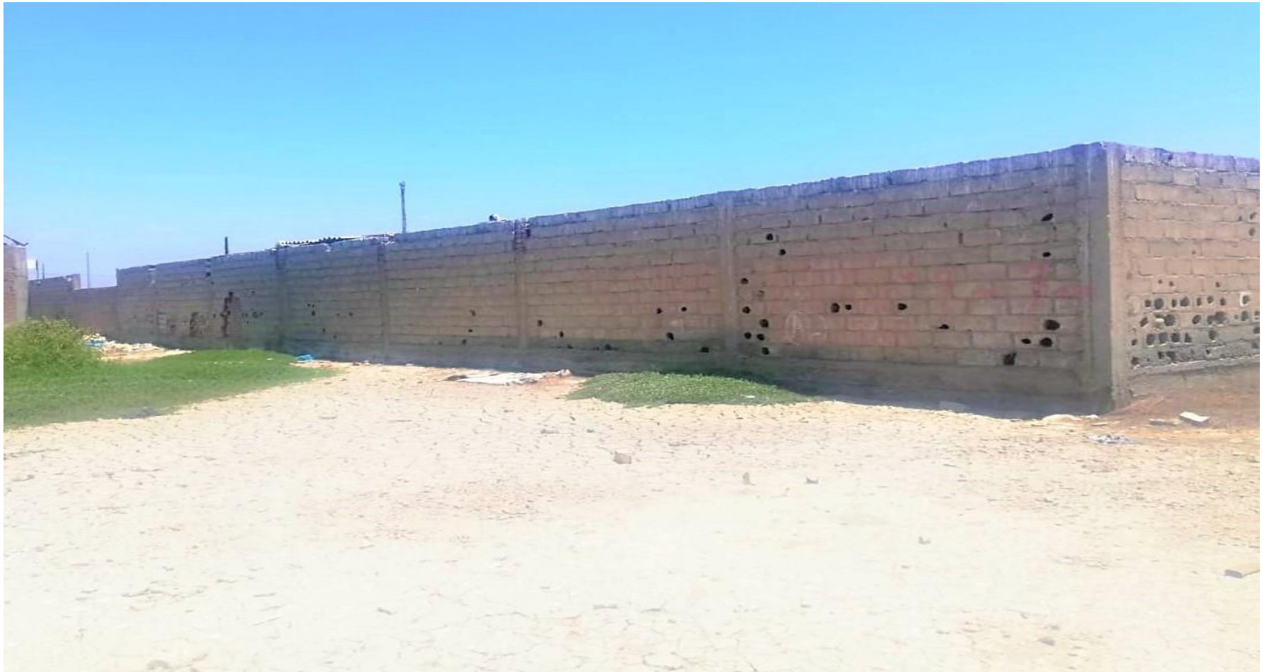
Gráfico 17. Fotografía de vista exterior del cerco del Mercado - Tramo 02
