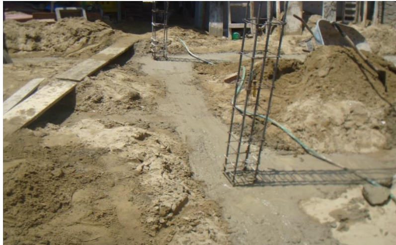
Gráfico 4 . Fotografía de cimiento corrido de una vivienda (Fuente: Investigación propia. 2019)
