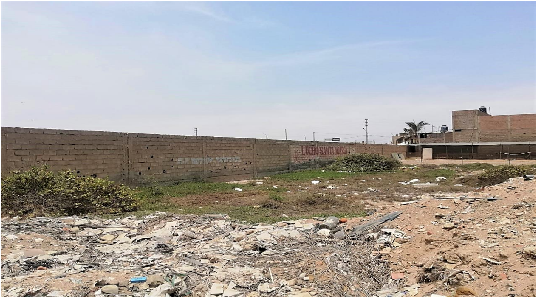
Gráfico 19. Fotografía de vista exterior del cerco del Mercado - Tramo 04
