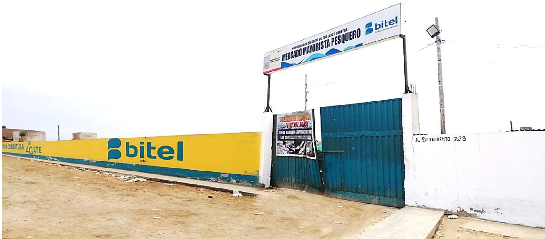
Gráfico 16. Fotografía de Vista exterior del cerco del Mercado – Tramo 01
