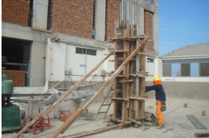
Gráfico 6 .Fotografía de encofrado de columna.
