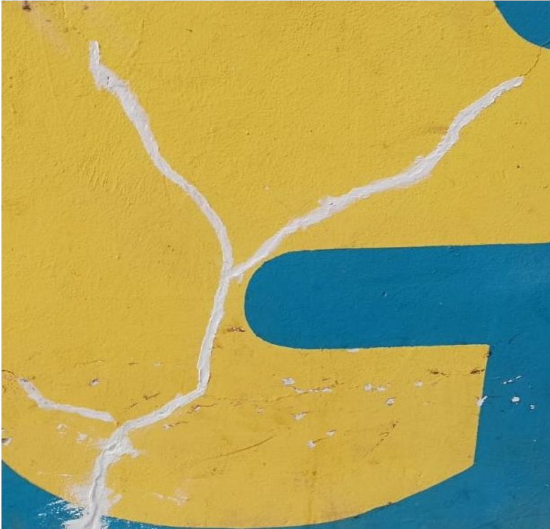
Gráfico 32 . Fotografía de reparación por grieta finalizado
