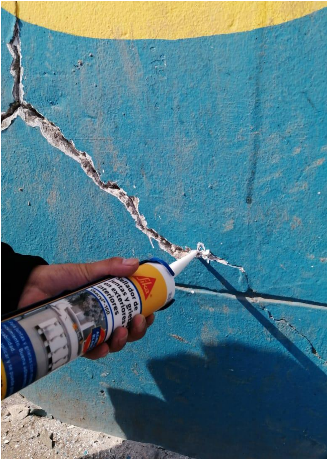
Gráfico 30. Fotografía de reparación de grietas utilizando SikaCryl 150 Fuente: Elaboración propia, 2020.
