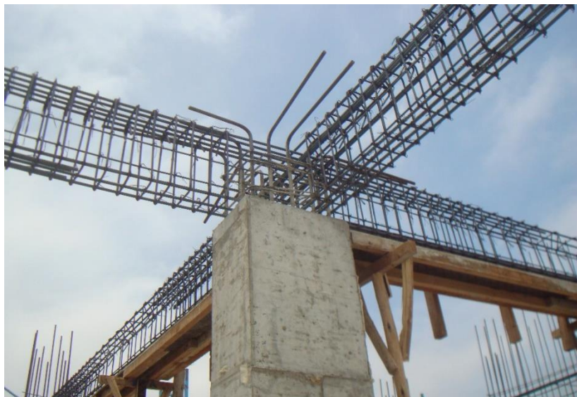
Gráfico 7 . Fotografía de acero en vigas
