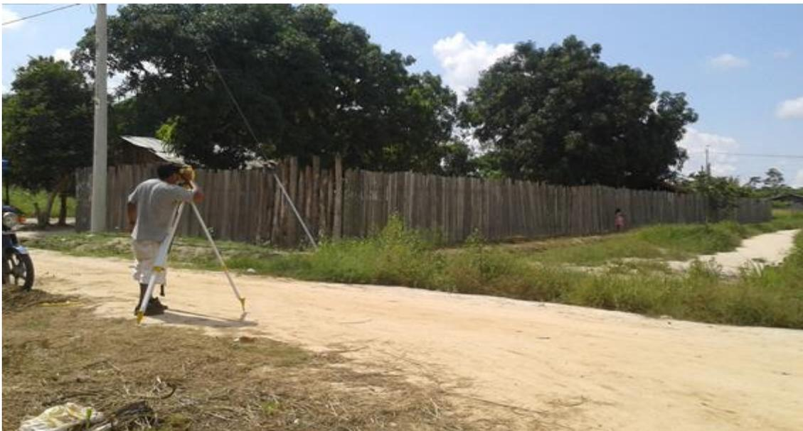
**Fotografía 04:** Levantamiento topográfico de las calles aledañas y viviendas donde se realizará la línea de distribución y conexiones domiciliarias.
