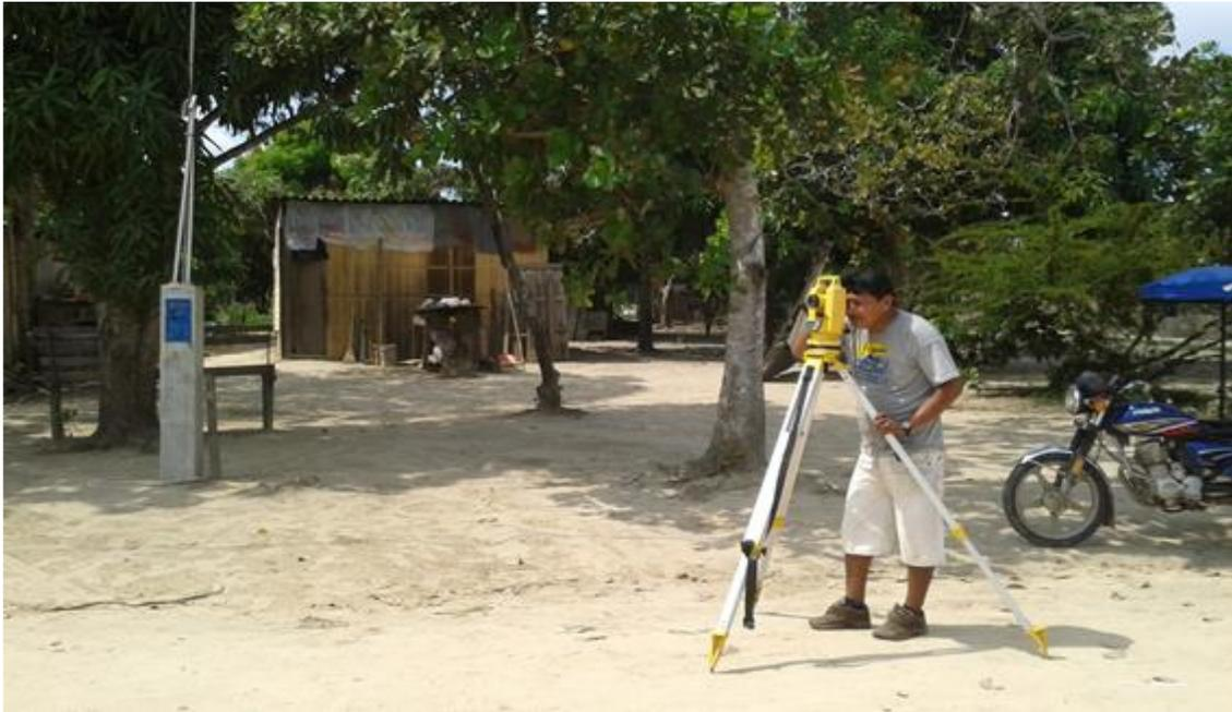
**Fotografía 01:** se observa el levantamiento topográfico realizado en el terreno para la construcción del sistema de agua potable.
