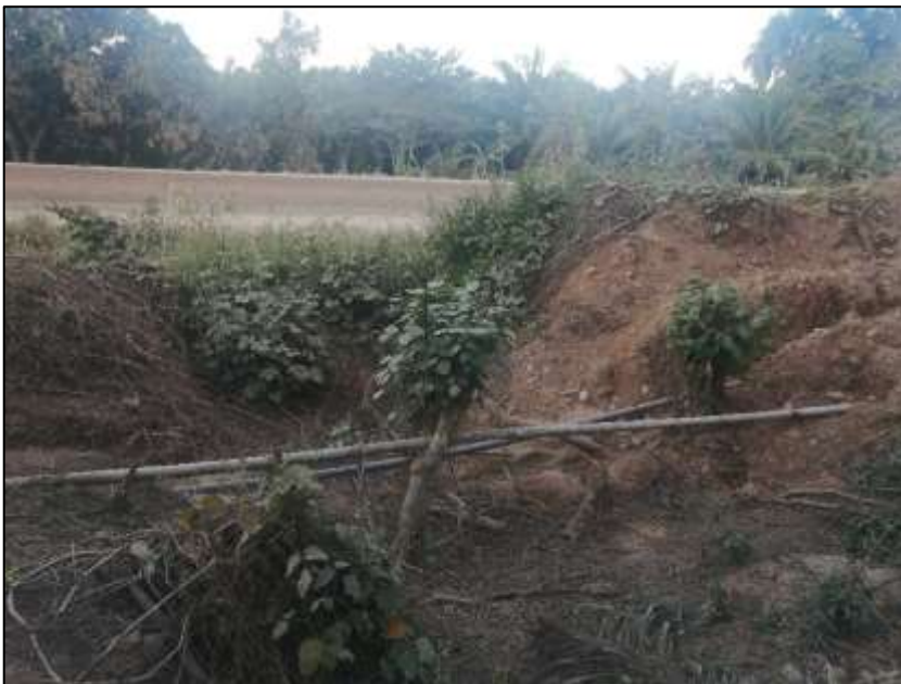
Imagen 5. Tramo expuesto carretera Neshuya-Cumaná
