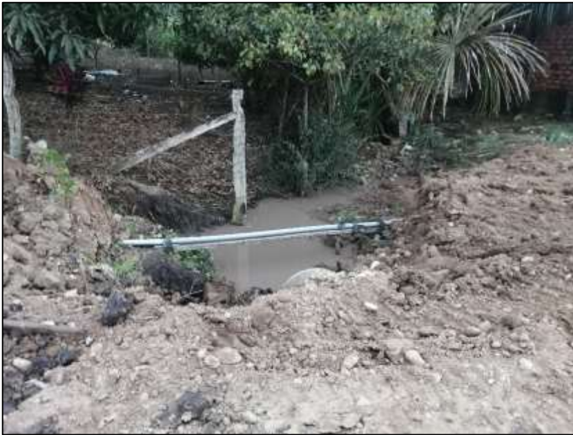
Imagen 4. Líneas de conducción expuestas
