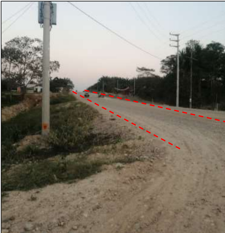
Imagen 9. Línea de conducción por la carretera Neshuya Curimaná.
