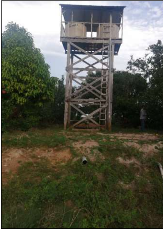
Imagen 6. Tanque elevado existente 01
