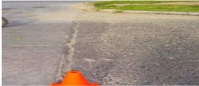
Figura 2. 19: Desplazamiento
