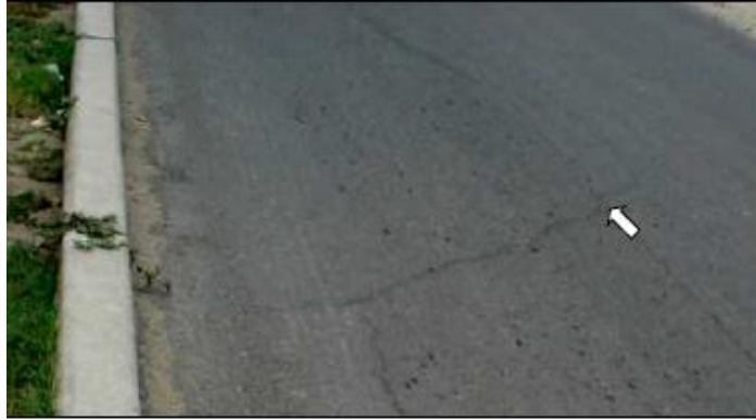
Figura 2. 20: Grieta parabólica
