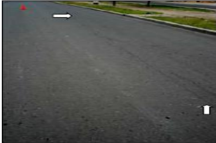
Figura 2. 18: Ahuellamiento
