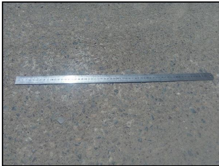
Figura D6. Pavimento con presencia de pulimento de agregados ubicado en la Avenida El Cementerio. Fuente: Elaboración propia.
