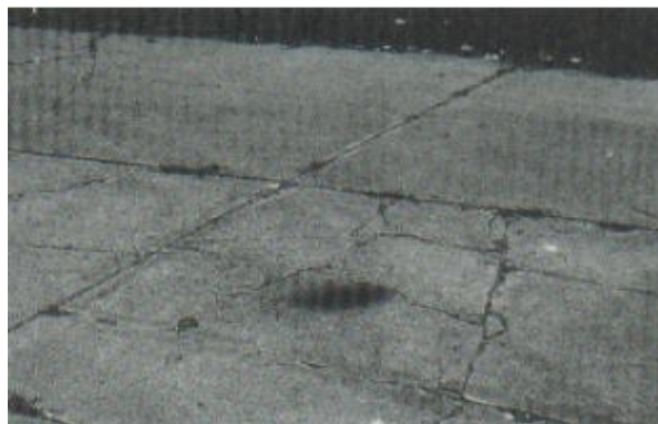
Figura 9. Losa dividida de severidad alta. Fuente: ASTM D6433-03.
