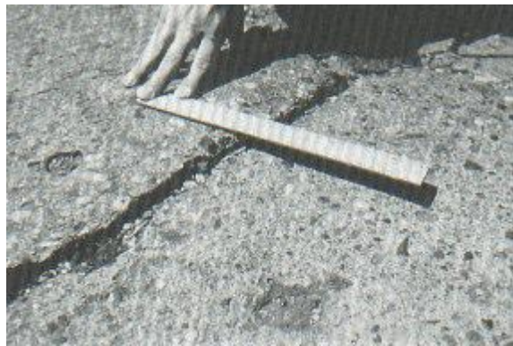
Figura 14. Escala de severidad media. Fuente: ASTM D6433-03.
