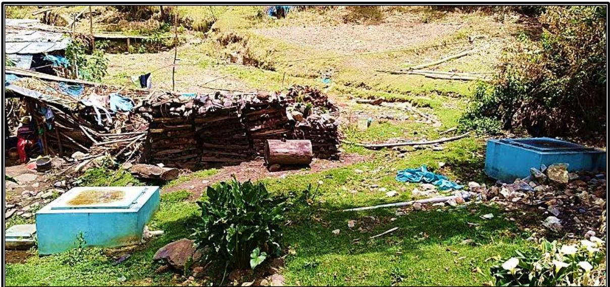
*Fotografía 2. De derecha a izquierda, captación y cámara rompe presión tipo 6.*
