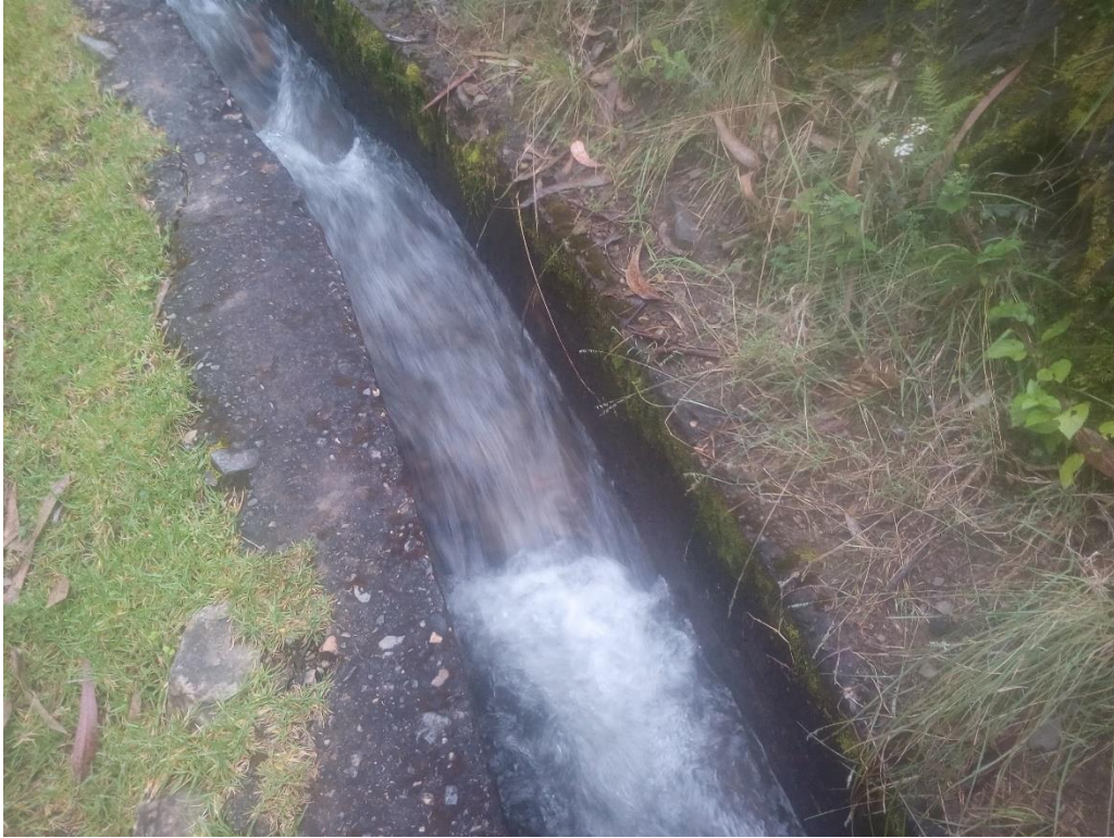
Imagen 16. Se puede observar que la velocidad de la agua es excesiva
