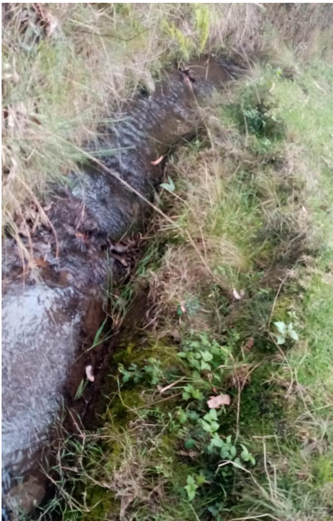
Imagen 13. Erosión y vegetación de la pared del canal
