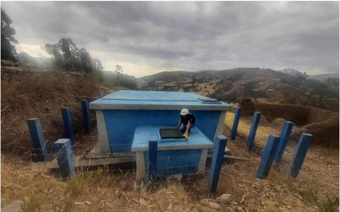
Fotografía 6: Cerco perimétrico del reservorio
