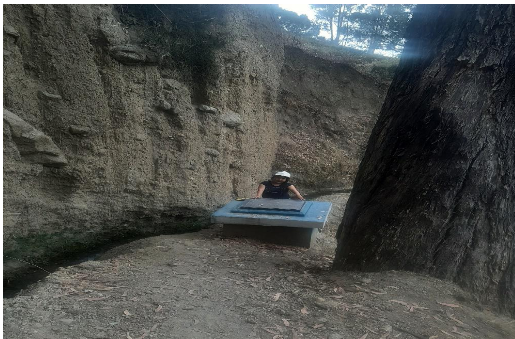
Fotografía 3: Cámara rompe presión
