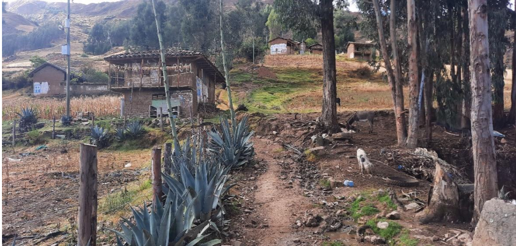
Imagen 9: Vista panorámica de las viviendas y la red de distribución del sistema de agua potable para el barrio de Rogaco.
