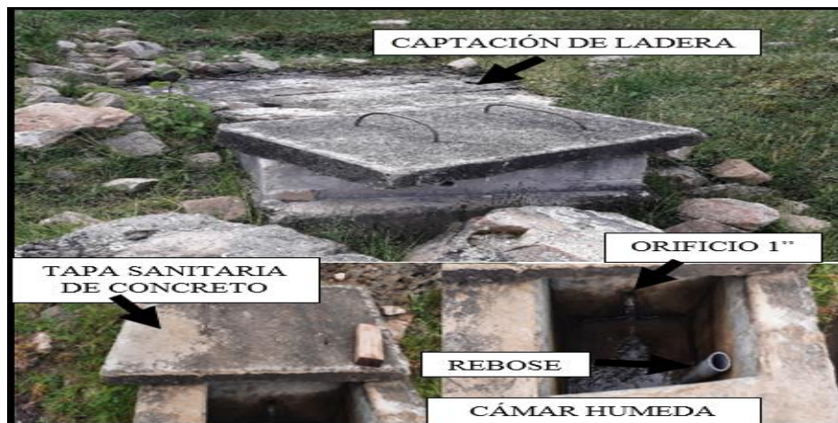
Figura 9: Evaluación del estado de la Captación.
