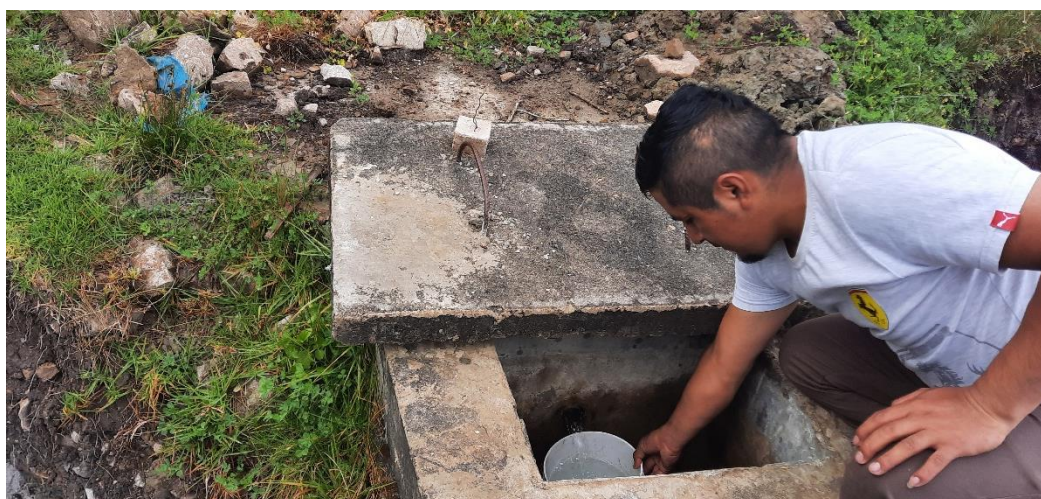
Imagen 4: Realización del aforamiento de la fuente Pilanco para el barrio de Rogaco, distrito Sicsibamba, provincia Sihuas, región Áncash.
