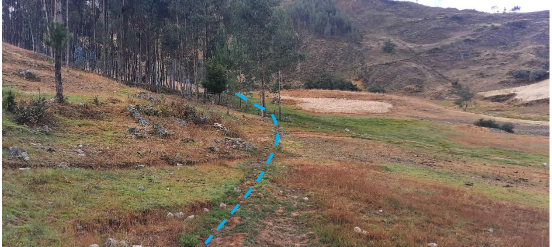
Imagen 5: Vista panorámica del trazado de la línea de conducción para el abastecimiento de agua en el barrio de Rogaco.
