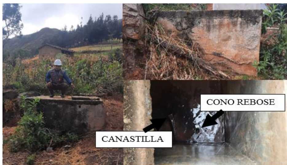
Figura 11: Evaluación del estado del Reservorio.
