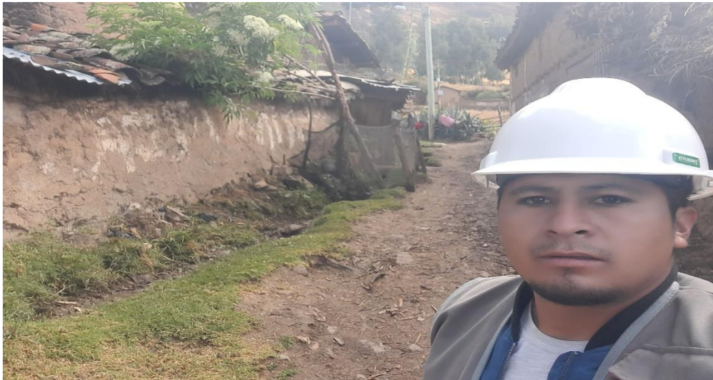
Imagen 10: Vista panorámica de las viviendas y la calle por donde será la red de distribución del sistema de agua potable para el barrio de Rogaco.
