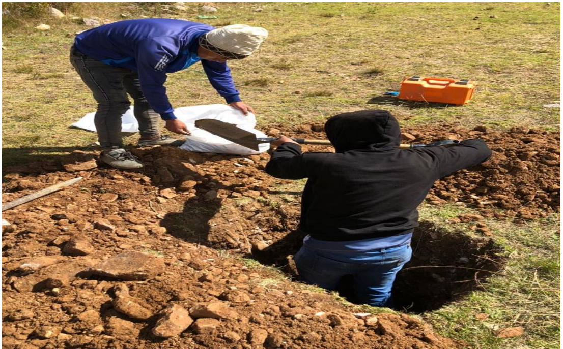
Imagen 6: Realización de la calicata en el reservorio de almacenamiento de agua proyectado para el barrio de Rogaco.
