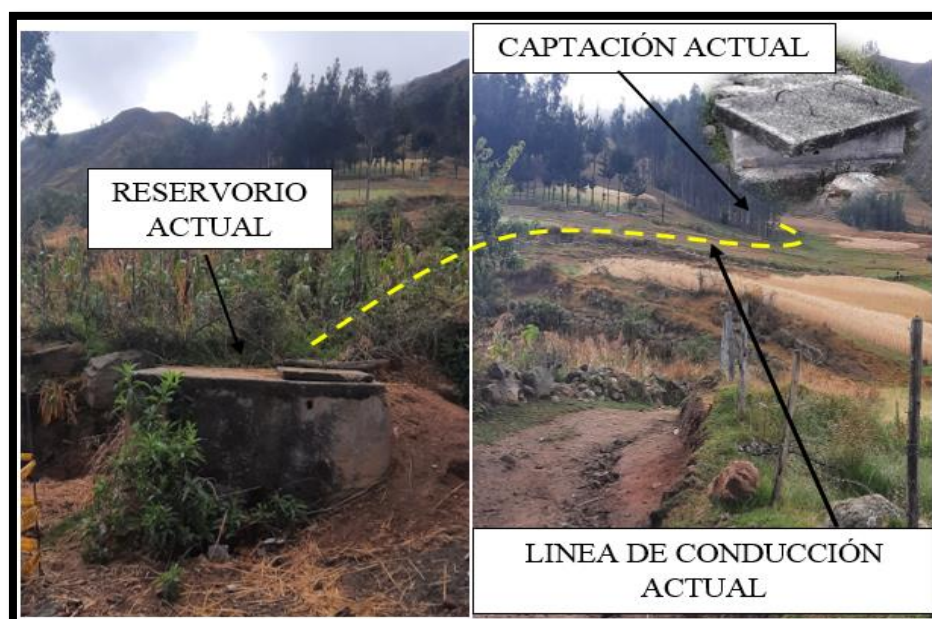
Figura 10: Evaluación del estado de la Línea de Conducción.
