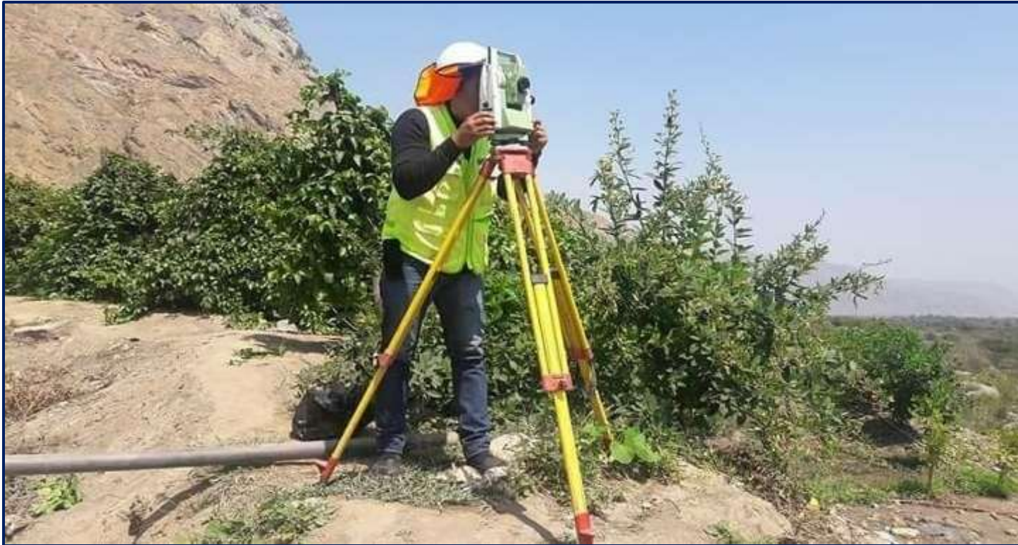
Imagen N°2: Realizando el levantamiento topográfico en el caserío de Huamanzaña
