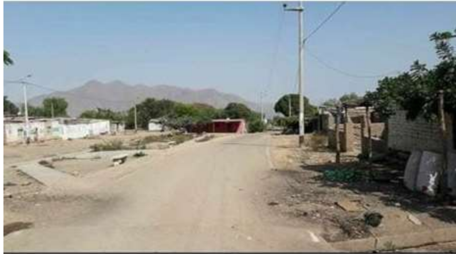
Imagen N°05: se puede apreciar las calicatas realizadas en el caserío de Huamanzaña.
