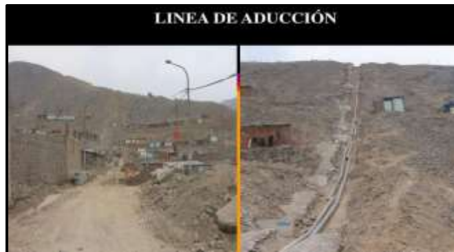
Figura 11: Línea de Aducción.
