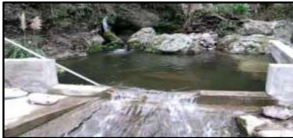
Figura 7: Captación de Agua en Ríos Nota. Fuente: UNAS. (2009).
