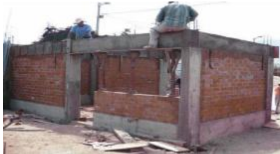
Imagen 06: Estructuración de la albañilería confinada
