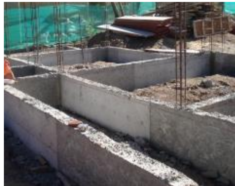
Imagen 09: Sobrecimientos armados
