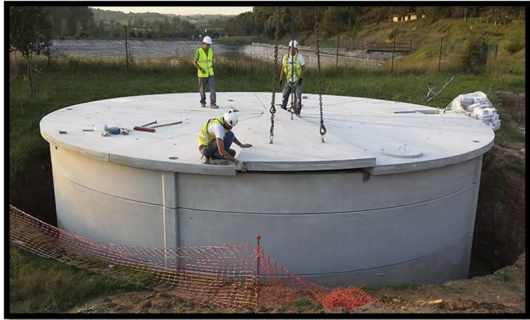
Figura 18. Reservorio enterrado.
