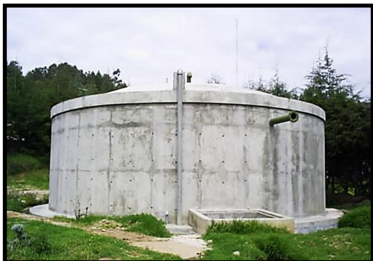
Figura 17. Reservorio apoyado.
