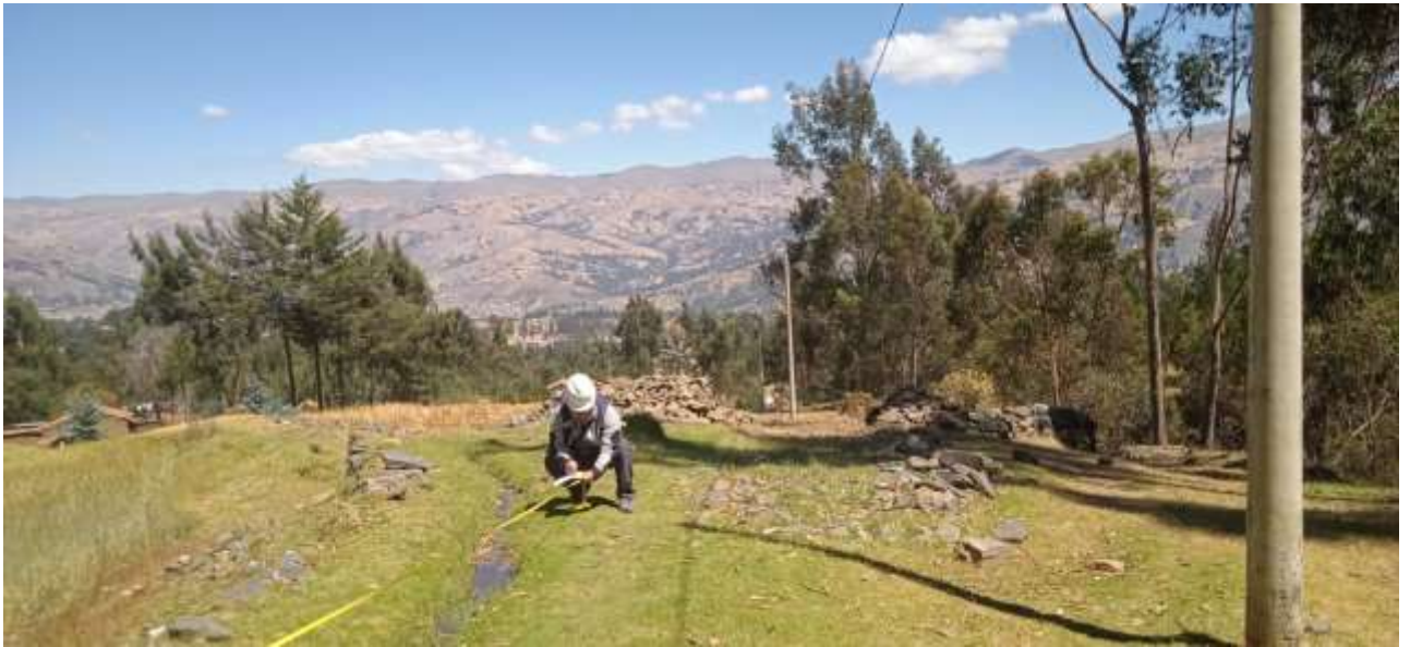
Fotografía 2 caserío shumpillam trazo de la tubería de conducción
