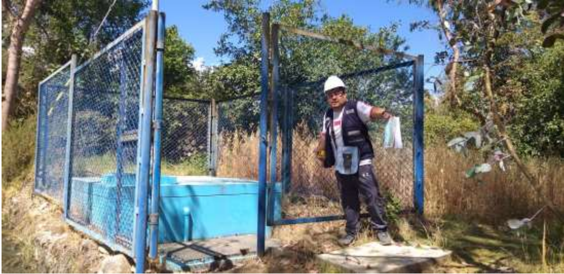
Fotografía 3 reservorio de almacenamiento de agua potable
