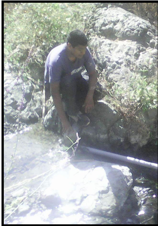
Fotografía 3. Se realiza el afloramiento en el manantial
