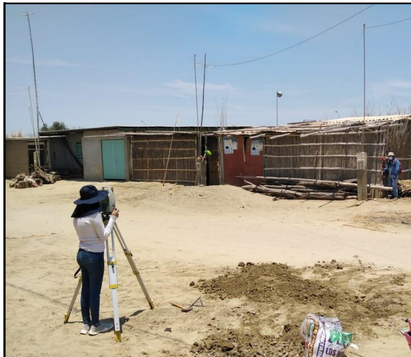
Fotografía 8. Realizando la topografía
