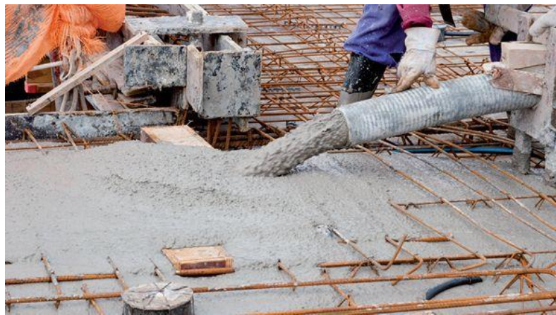
Grafico 6: Concreto en losa aligerada.
