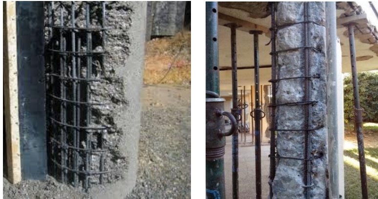
Grafico 7: Patologías en columnas de concreto armado.
