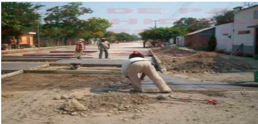
Figura 2: Construcción de un pavimento rígido
