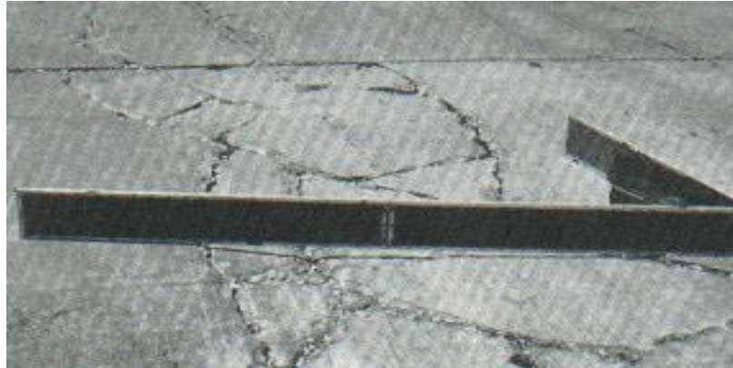
Figura 23: Falla Punzonamiento
