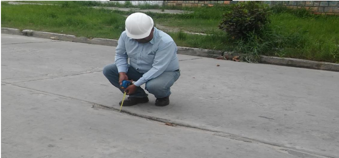
Figura 136: Jirón Sargento lores cuadra 14. Se observa falla Escala
