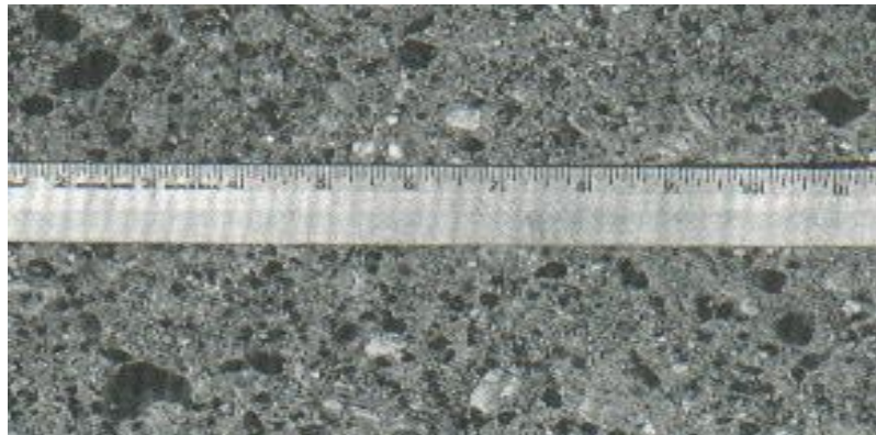
Figura 20: Falla Pulimento de Agregado
