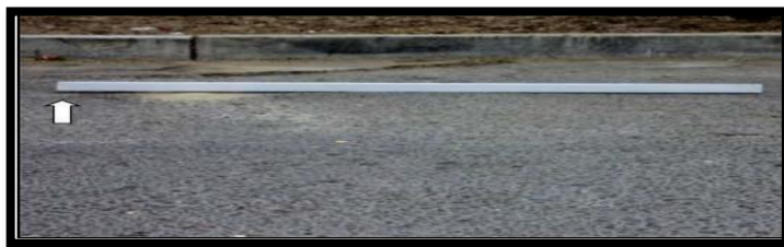
Gráfico 8: Desplazamiento hacia arriba de la superficie del pavimento
