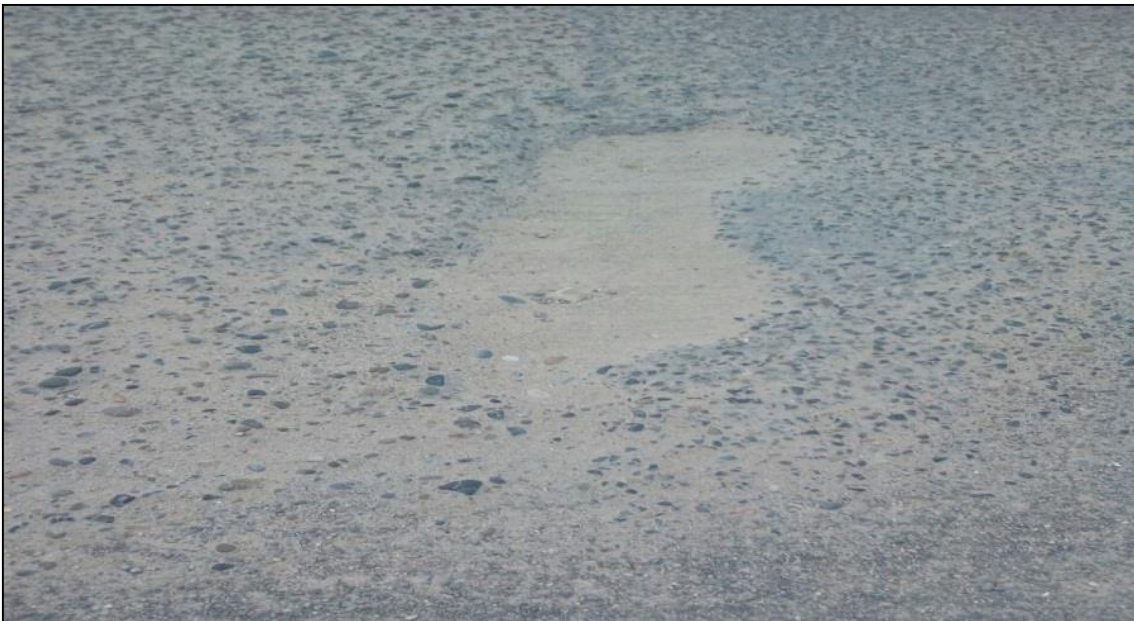
Imagen 4: Área de inspección visual de la zona de estudio
