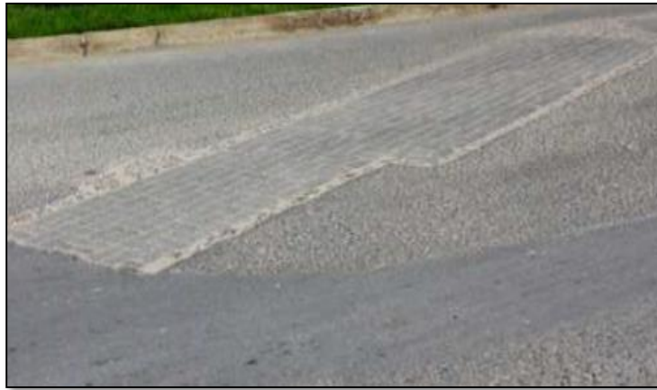
Gráfico 15: Área del pavimento es remplazada por bloquetas de concreto
