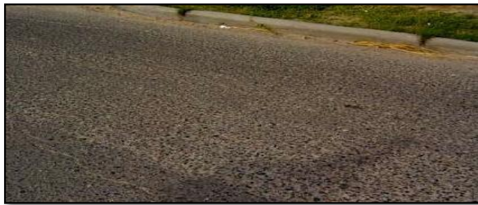
Gráfico 21: Peladura y desprendimiento de agregados.
