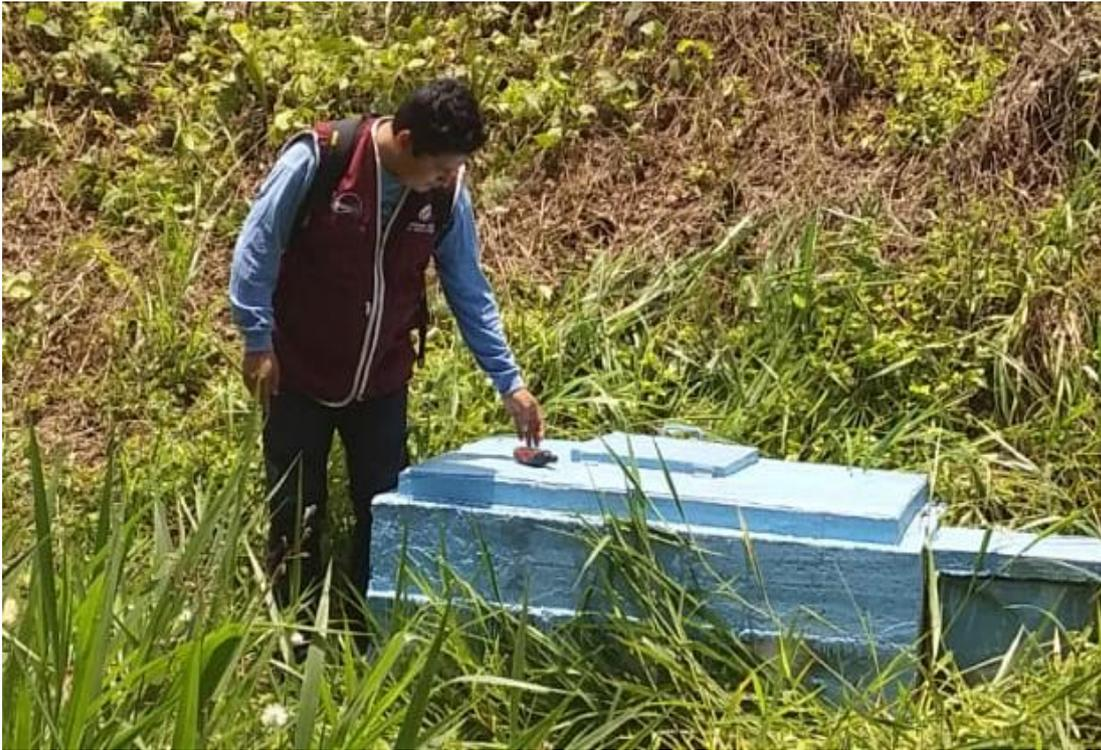
Figura 17;Identificando la camara de rompe presion de tipo 7
