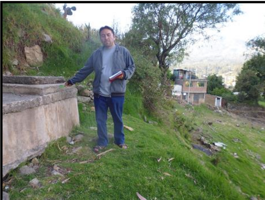
Captación de Cuis Quita cuenta con un caudal de 1.00 l/s se observa las condiciones en las que se encuentra
