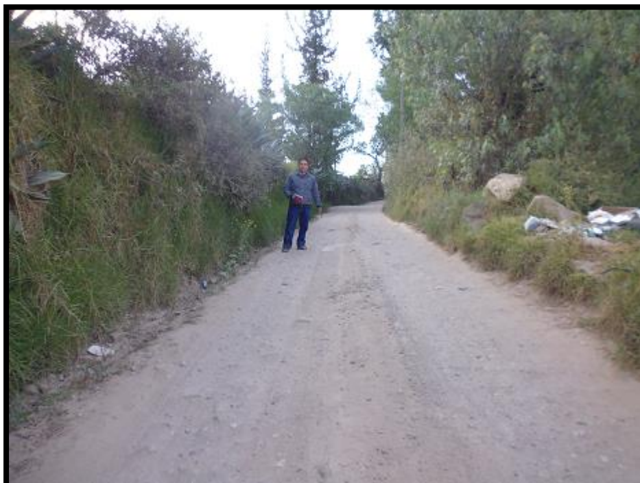
Se observa otro de las buzonetas del sistema de alcantarillado sanitario condominial sector central
