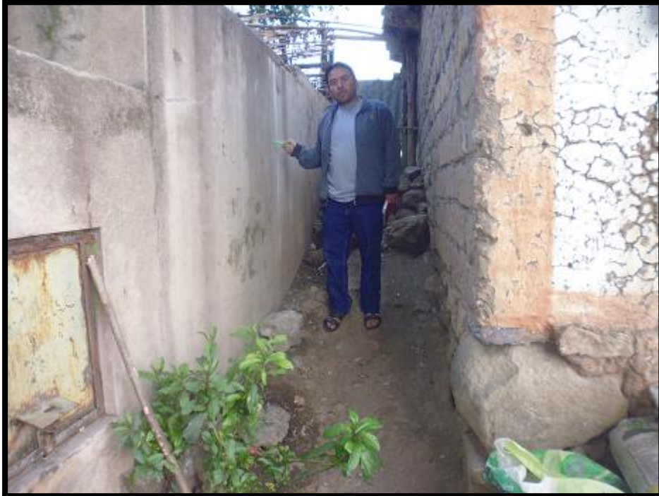
Reservorio de almacenamiento N° 01 V=10m^3 de capacidad se observa el estado en la que se encuentra
