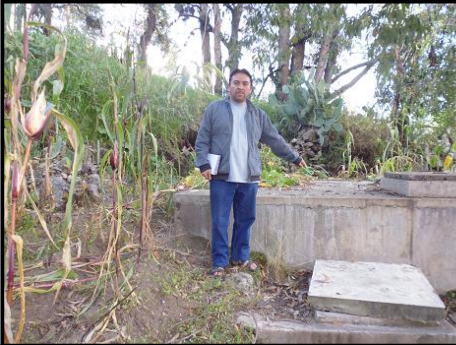
Reservorio de almacenamiento N° 02 Capacidad de almacenamiento de V=10m^3 , se observa el estado en que se encuentra
