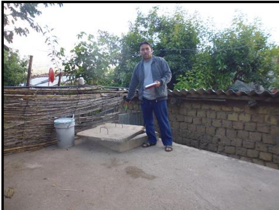
Otra vista fotográfica del reservorio de almacenamiento N° 01
