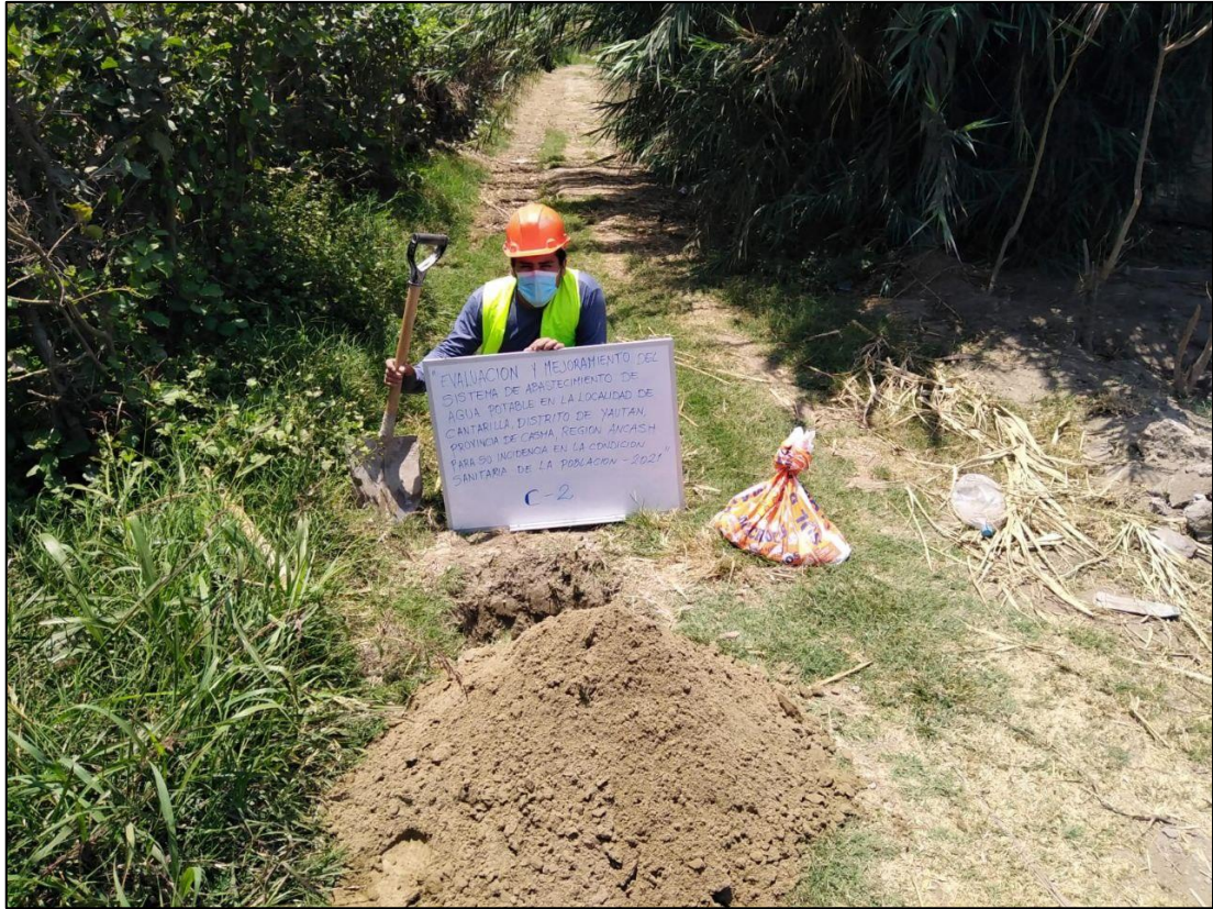
Imágen 10 Calicata para ensayo de mecánica de suelos
