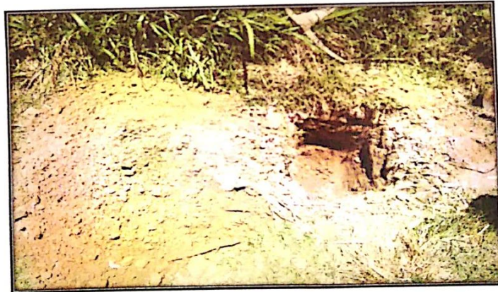
Excavación de calicata C-01 profundidad 1.20m
