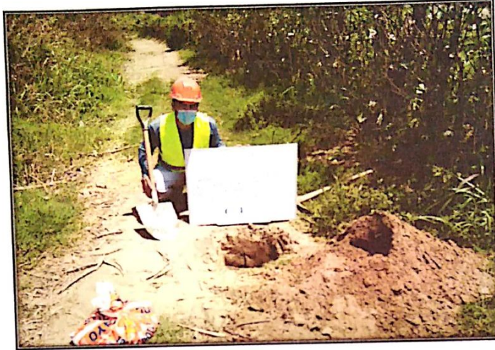
Excavación de calicata C-01
