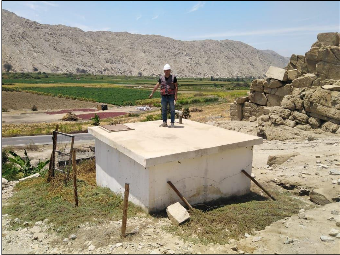
Imágen 8 Reservorio apoyado rectangular
