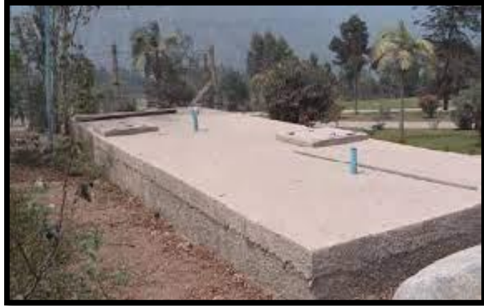
Figura 14 Reservorio enterrado
