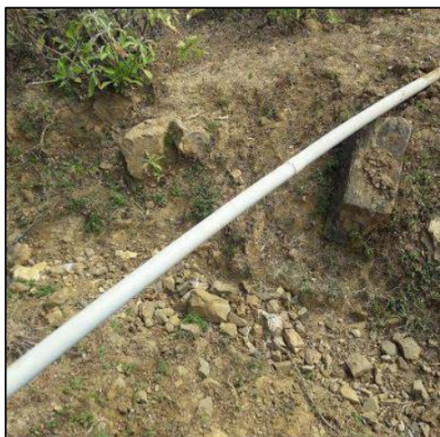
Imágen 3 Línea de conducción expuesta al terreno
