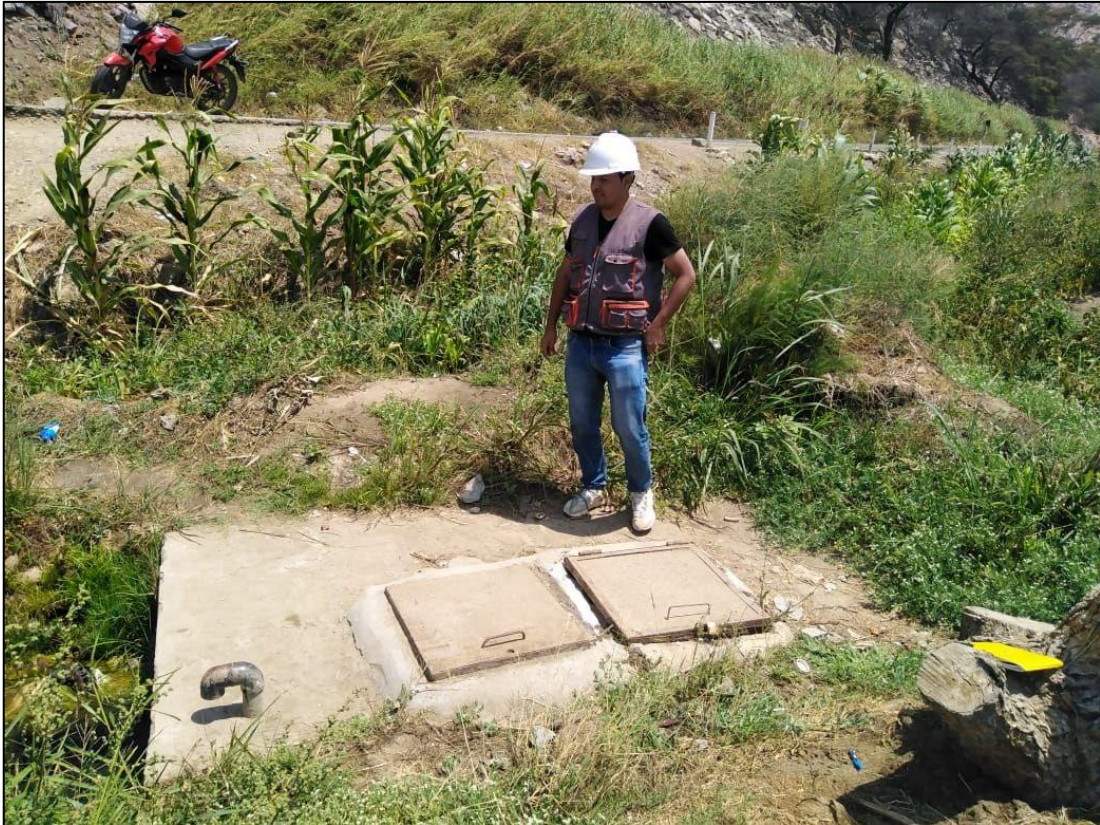
Imágen 1 Obra de captación por manantial tipo fondo de localidad Cantarilla
