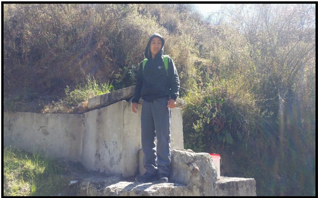
Imagen 6: Se observa la captación y el balde con el que se hizo la medición del caudal
