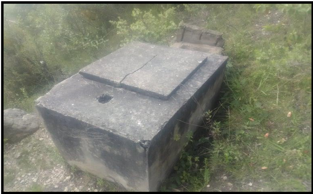
Imagen 3. CRP tipo 6 – se encuentra en mal estado.
