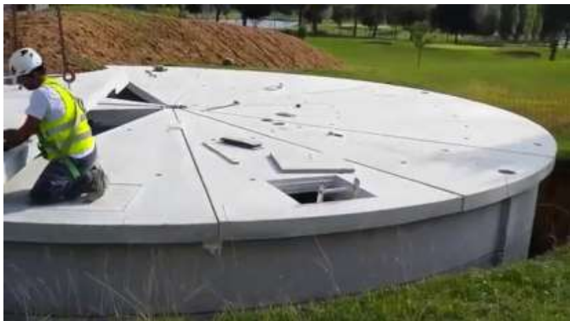
imagen 15 reservorio circular enterrado
