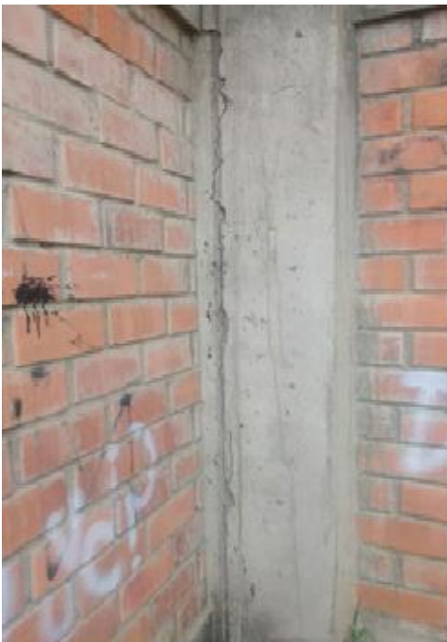
Vista interior lado norte con patologías como grieta y fisuras en columna (UM 7-A). del cerco perimétrico del campo deportivo de la Institución Educativa Simón Antonio Bolívar Palacios en el distrito de Independencia, provincia Huaraz, departamento Áncash.
