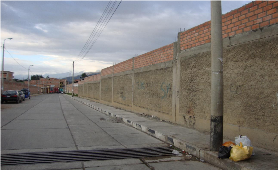
Vista exterior del cerco perimétrico lado oeste del campo deportivo de la Institución Educativa Simón Antonio Bolívar Palacios en el distrito de Independencia, provincia Huaraz, departamento Áncash.
