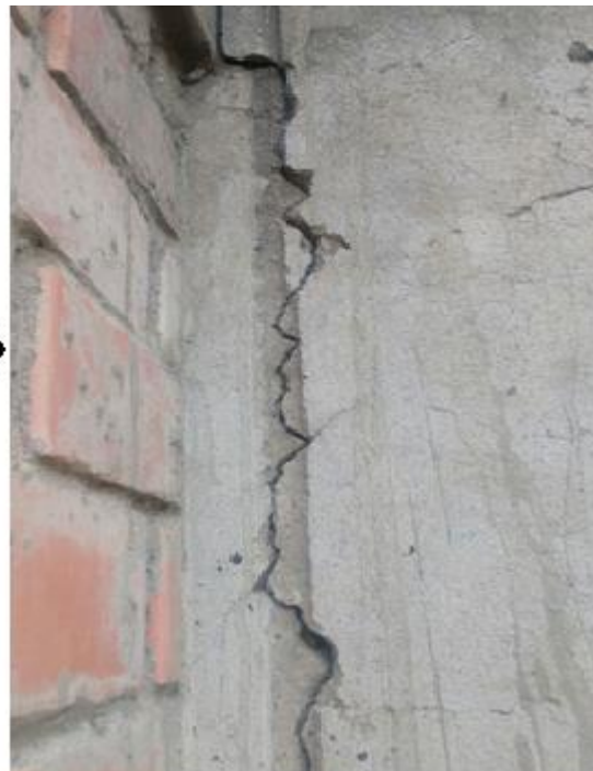
Vista interior lado norte con patologías como grieta y fisuras en columna (UM 7-A). del cerco perimétrico del campo deportivo de la Institución Educativa Simón Antonio Bolívar Palacios en el distrito de Independencia, provincia Huaraz, departamento Áncash.
