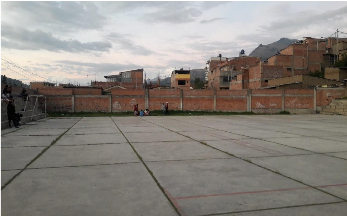
Vista interior del cerco perimétrico lado norte del campo deportivo de la Institución Educativa Simón Antonio Bolívar Palacios en el distrito de Independencia, provincia Huaraz, departamento Áncash.
