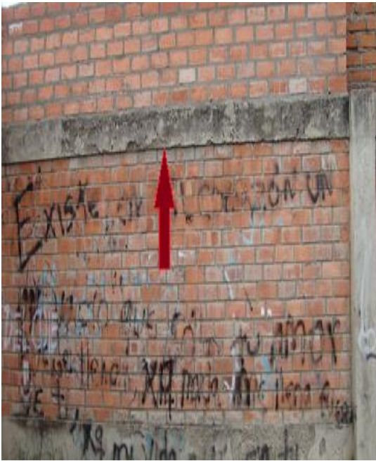
Vista interior del cerco perimétrico lado norte con patologías como desintegración, eflorescencia, fisuras del campo deportivo de la Institución Educativa Simón Antonio Bolívar Palacios en el distrito de Independencia, provincia Huaraz, departamento Áncash.
