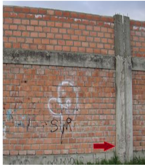
Vista interior del cerco perimétrico lado norte con patologías como desintegración, eflorescencia, fisuras del campo deportivo de la Institución Educativa Simón Antonio Bolívar Palacios en el distrito de Independencia, provincia Huaraz, departamento Áncash.
