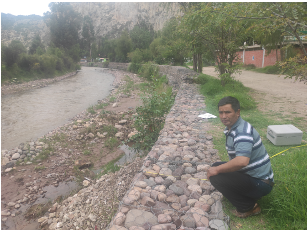
Figura 5.10: Medición del ancho de gavión.
