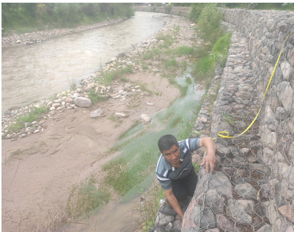
Figura 5.8: Medición de la altura de gavión. Fuente: Elaboración propia.
