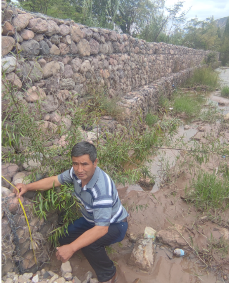
Figura 5.4: Medición de la altura de gavión. Fuente: Elaboración propia.
