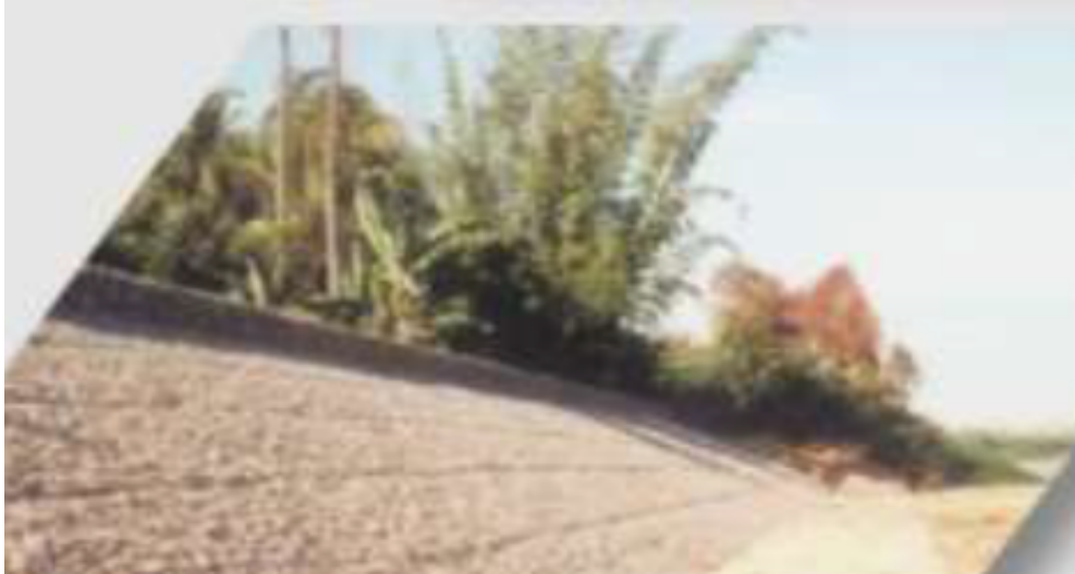
Figura 2.2: Obra longitudinal (Estructura delgada).
