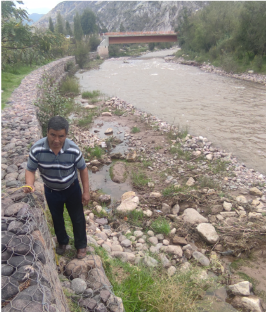
Figura 5.6: Medición de la altura de gavión.
