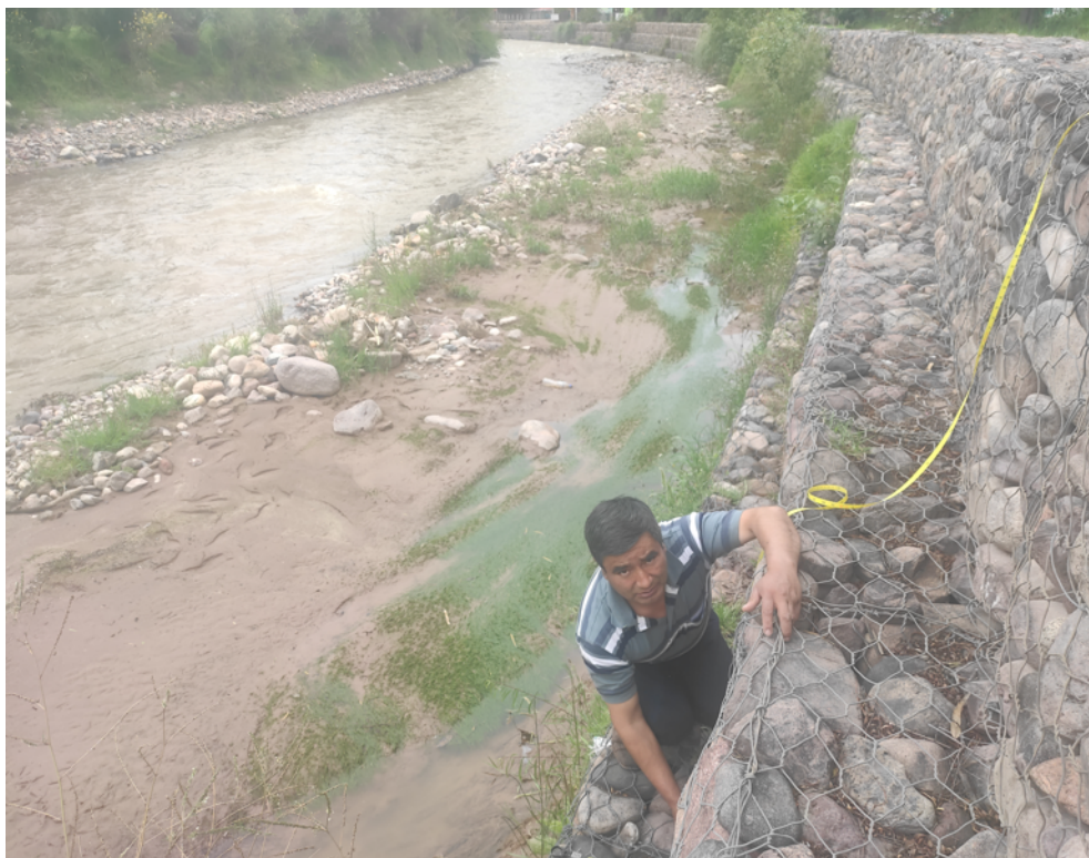
Figura 5.7: Medición de la altura de gavión. Fuente: Elaboración propia.
