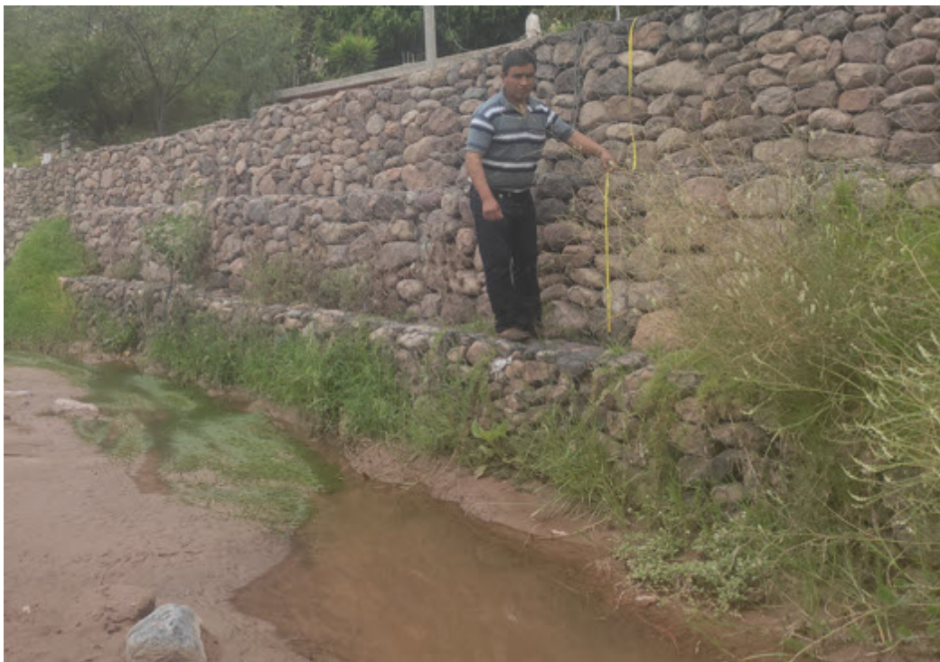
Fotografía 2: tomando medidas del gavión de tres niveles.
