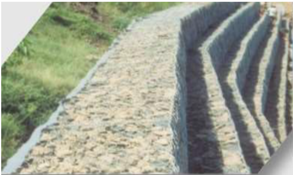
Figura 2.1: Obra longitudinal (Estructura gruesa).
