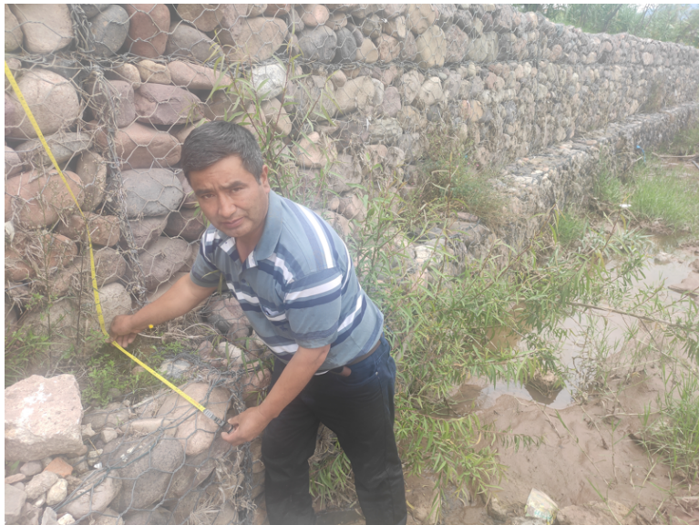
Figura 5.3: Medición de la altura de gavión.
