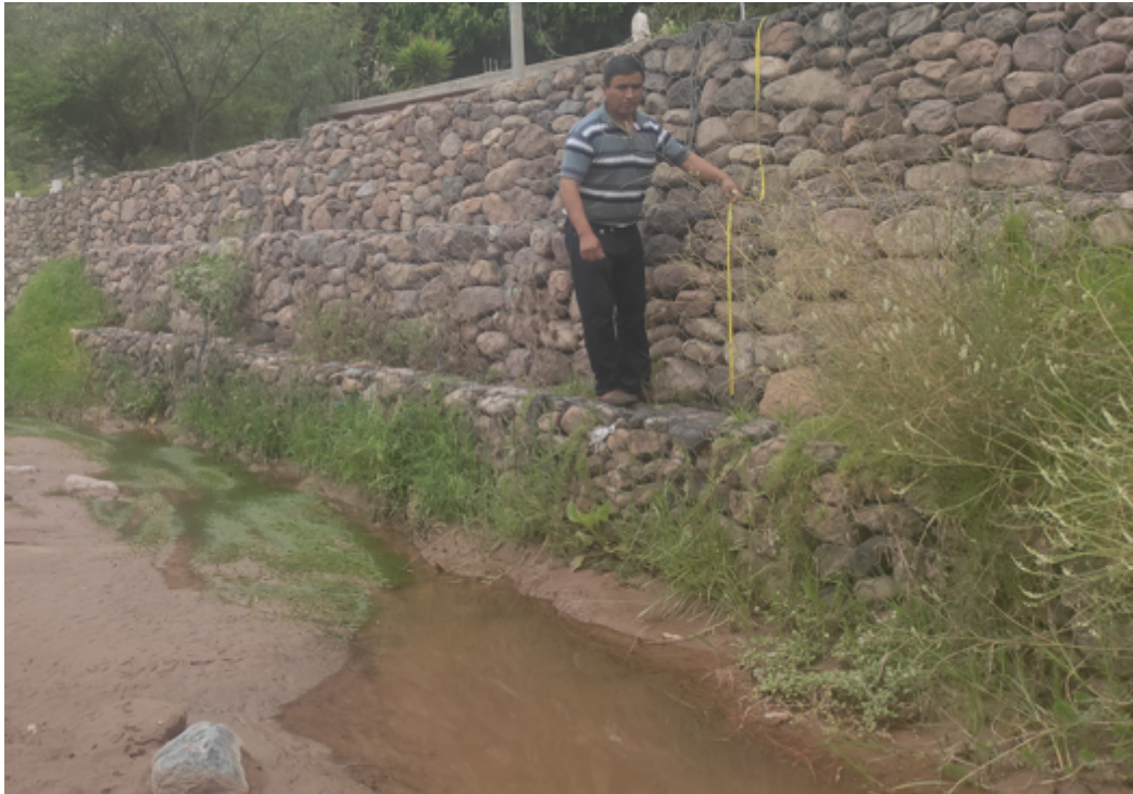
Figura 5.9: Medición de la altura de gavión.
