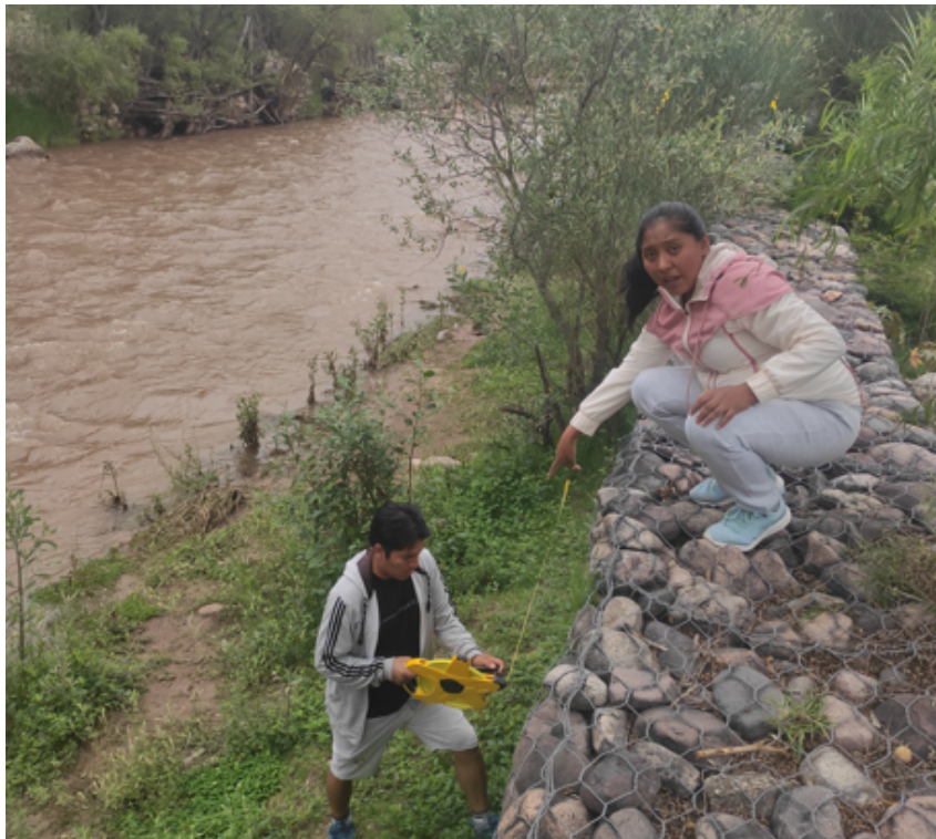
Figura 5.4: Medición del la altura de gavión.
