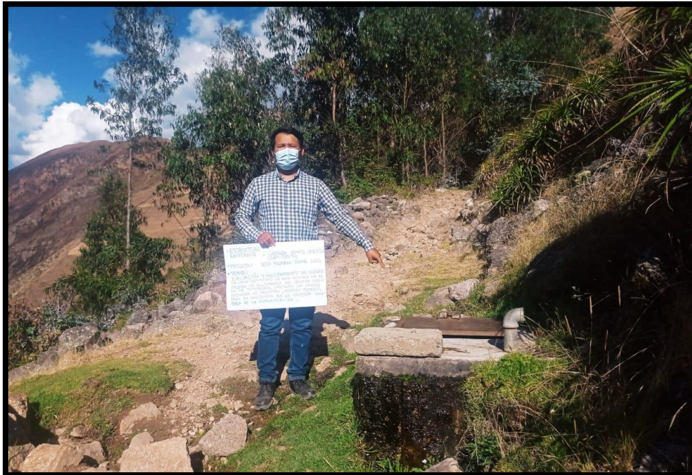
Imagen 18 Cámara rompe presión existente del Caserío de Allpamarca.
