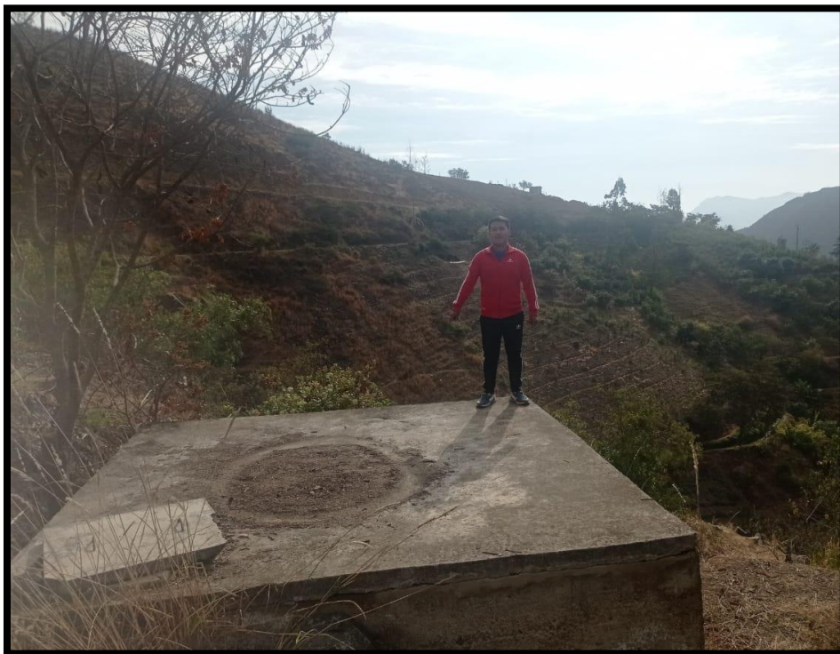
Imagen 5 Evaluación de Reservorio del Área N° 1, del caserío de Allpamarca.
