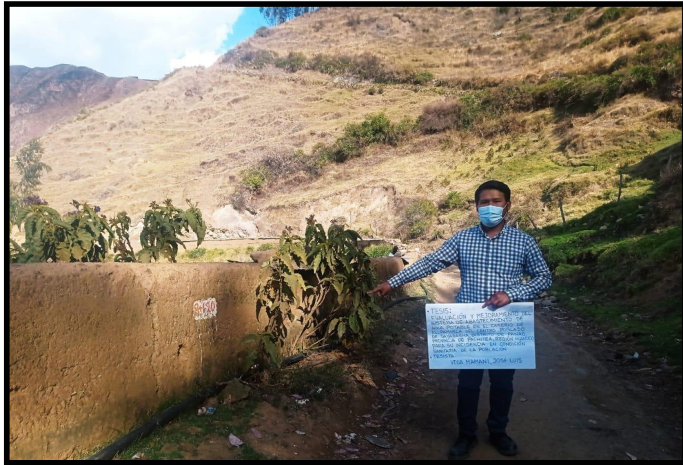
Imagen 19 Tubería HDPE de la línea de conducción existente del Caserío de Allpamarca.
