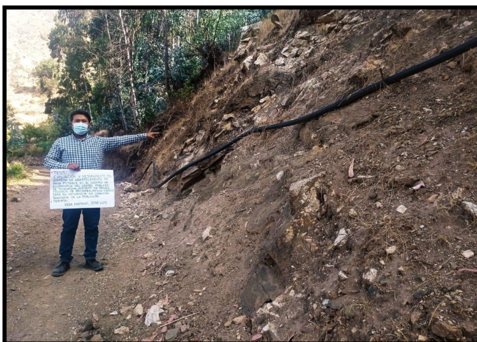
Imagen 3 Evaluación de la línea de conducción del caserío de Allpamarca – Área n° 1.
