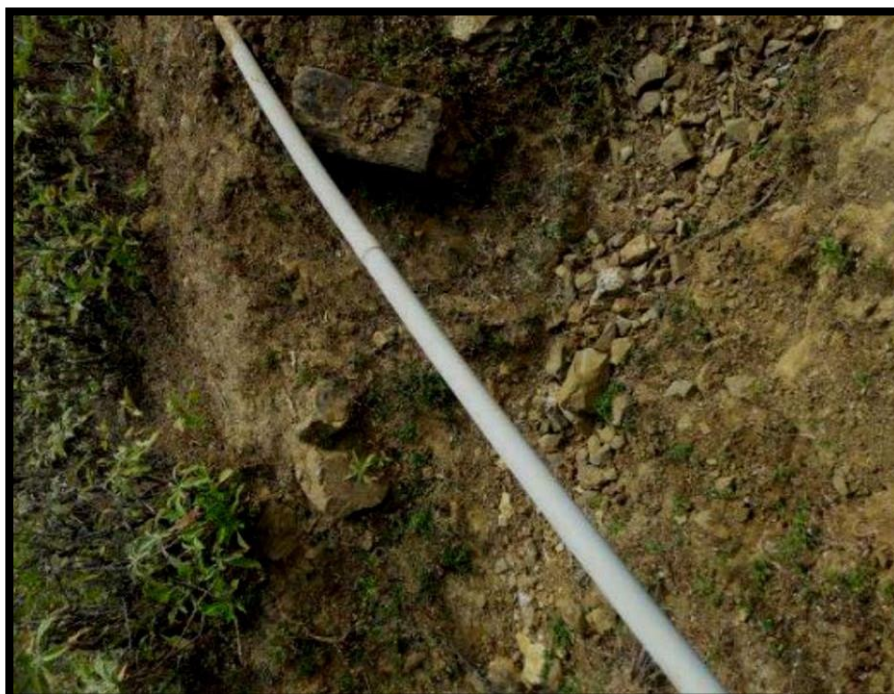
Imagen 4 Evaluación de la línea de conducción del caserío de
