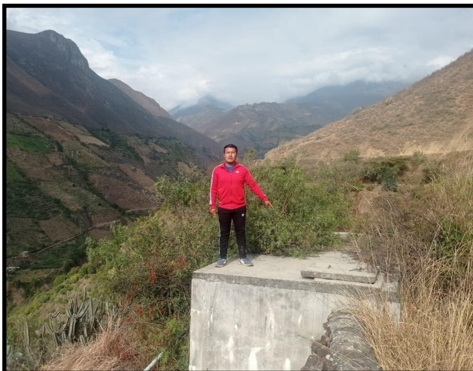
Imagen 7 Evaluación de Reservorio del Área N° 2, del caserío de Allpamarca.
