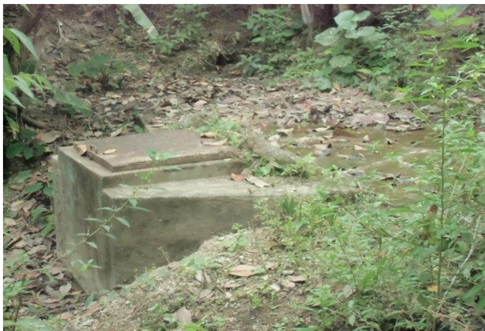
IMAGEN N° 04: CAPTACIÓN EXISTENTE DE MANANTIAL “EL GUAYAQUIL”
