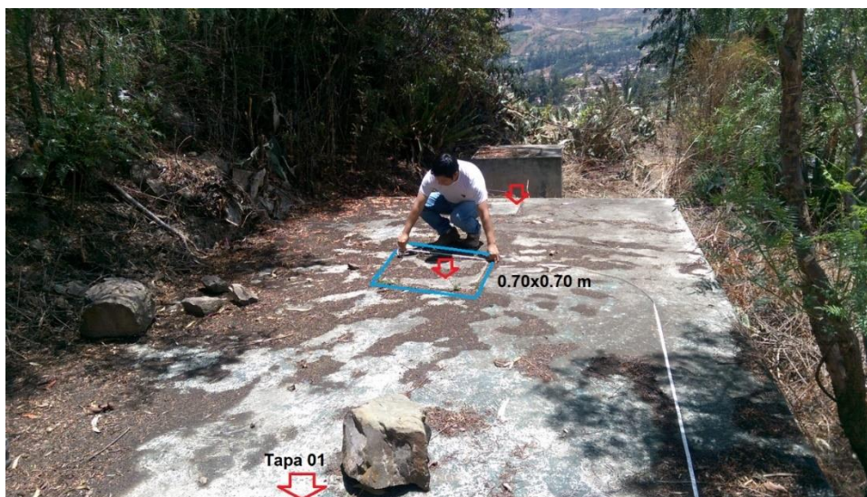
Imagen 17. Realizando el dimensionamiento de tapas sanitarias del tanque séptico
