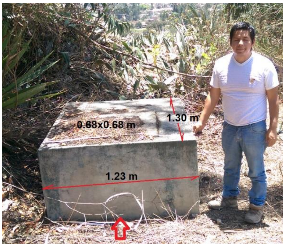
Imagen 18. Características físicas de la cámara de distribución
