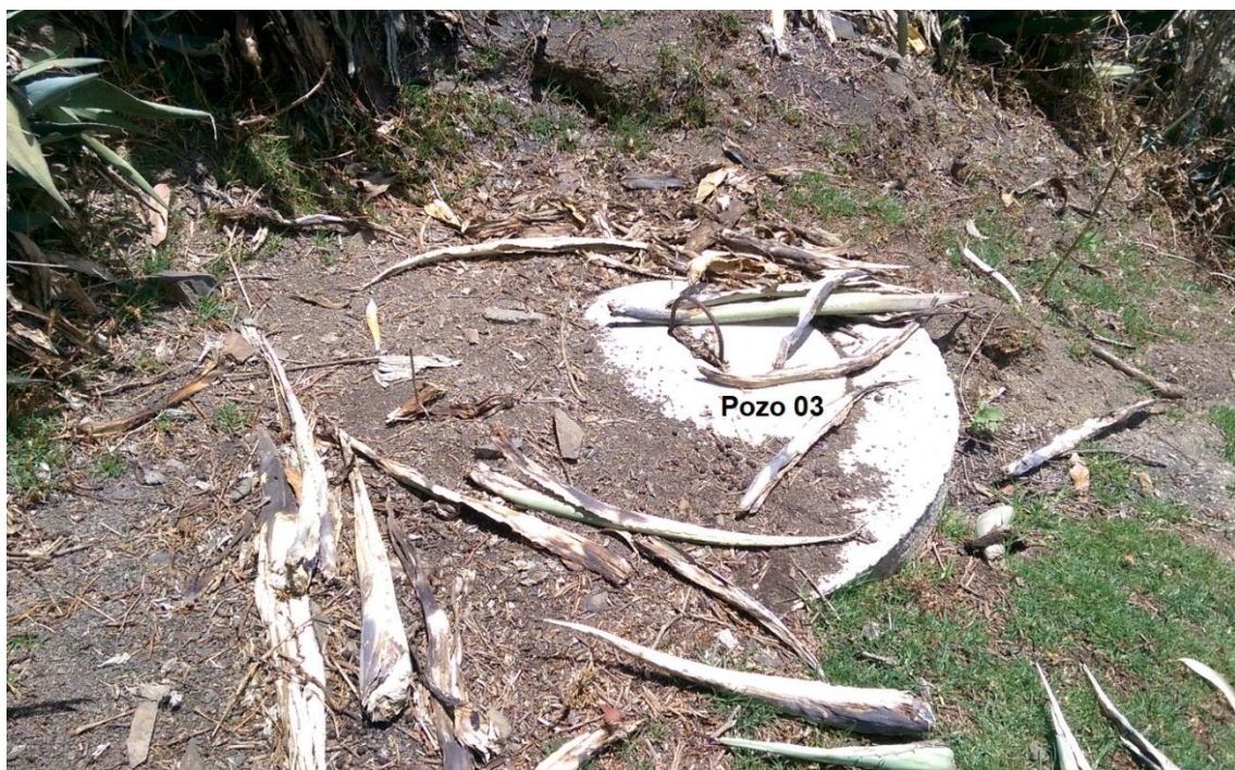
Imagen 21. Pozo de percolación 03; concreto simple de 1.45m de diámetro, 0.60 m de tapa.
