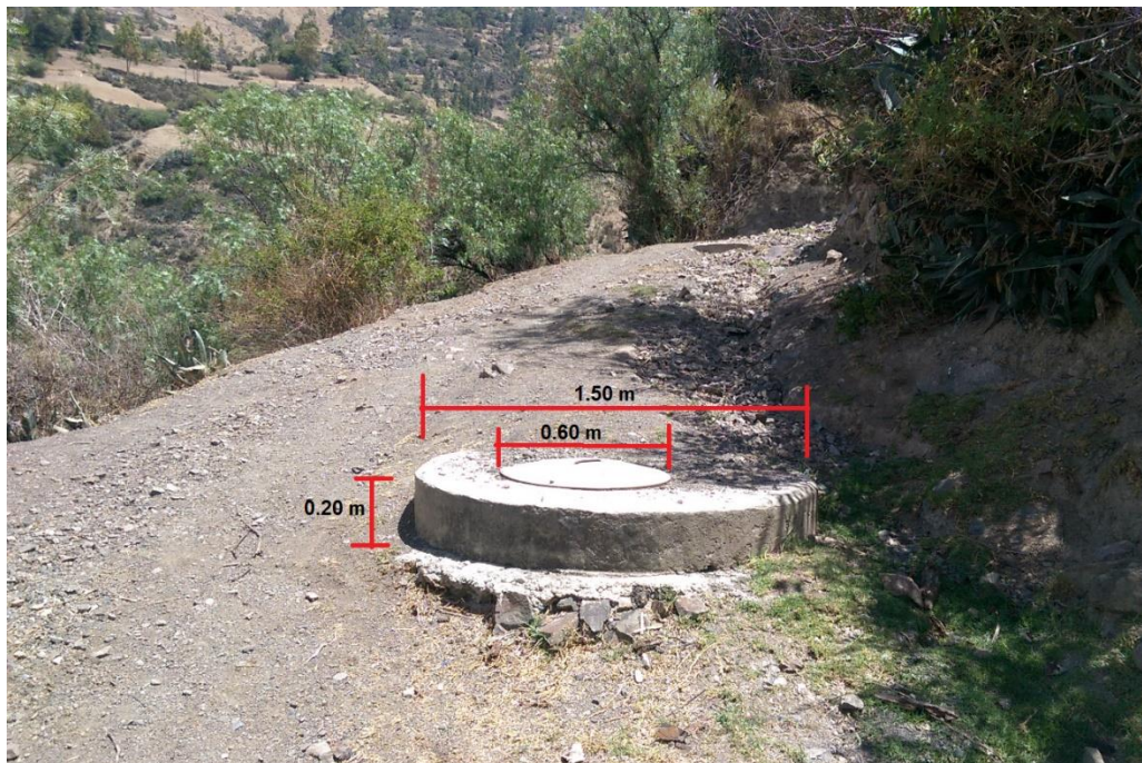
Imagen 12. Características físicas del Buzon, ubicado en las coordenadas E: 209406.00 m E; N: 8971255.00 m a una altitud de 2772 m.s.n.m.
