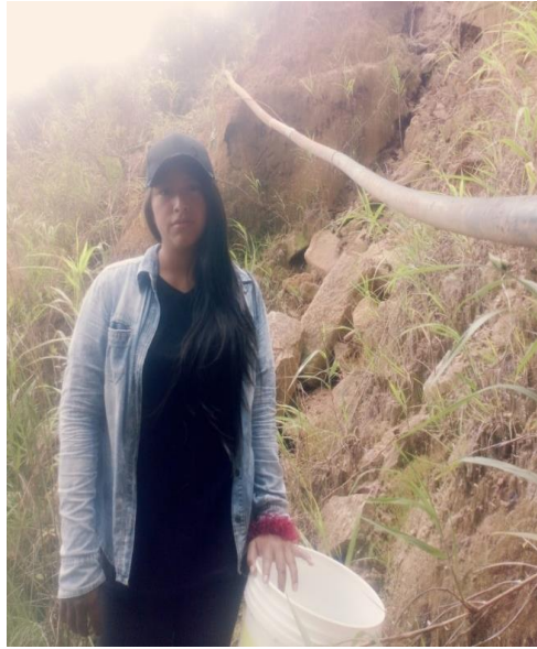
Tramo por donde atraveza la linea de conduccion, presenta desprendimiento de rocas y riesgos de derrumbes.
