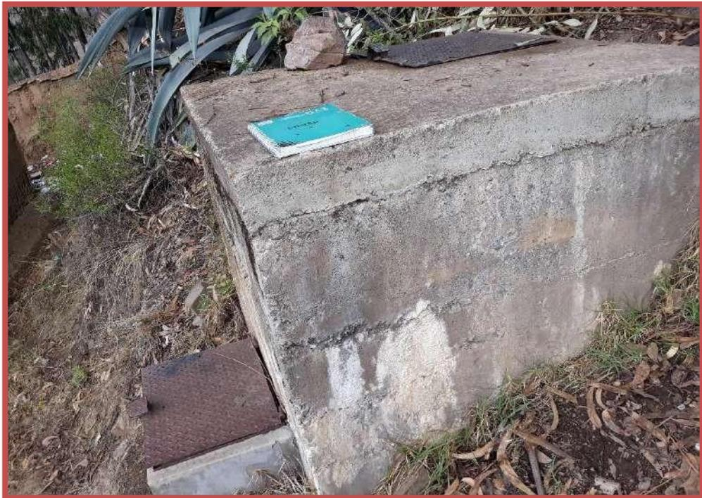
**Imagen 15.** Cámara rompe presión tipo 7 en malas condiciones
