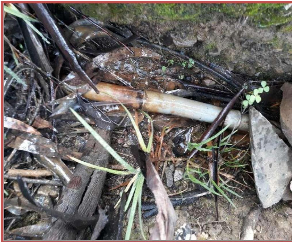
*Imagen 07.* Patologías presentadas en la tubería de la línea de aducción
