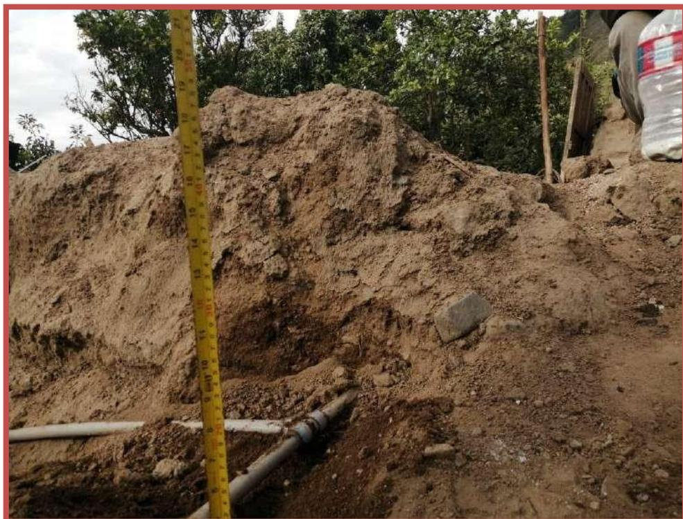
**Imagen 10.** Red de distribución expuesta a la intemperie (tubería secundaria)
