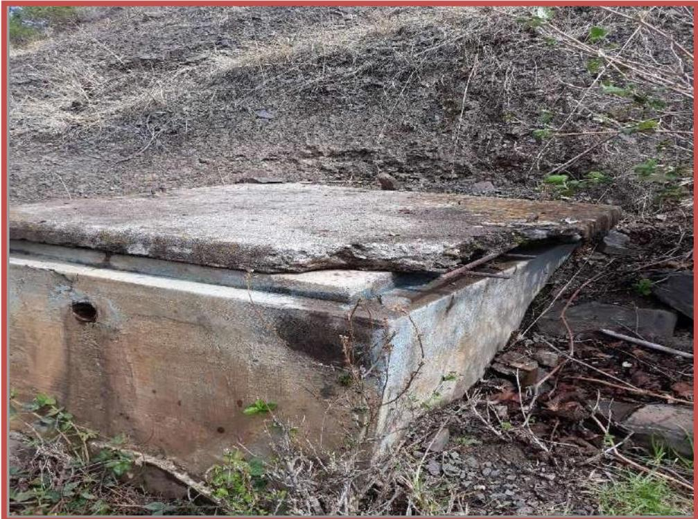
**Imagen 13.** Estructura de la Cámara rompe presión tipo 6 deteriorada.
