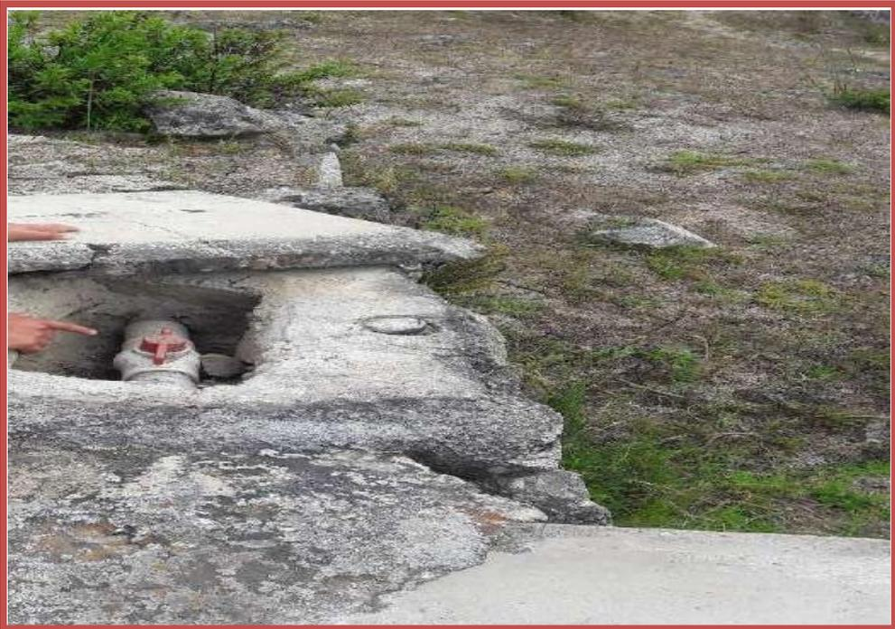
*Imagen 11.* Válvulas de control de la red expuesta a la intemperie cubierta solamente con una caja de concreto.
