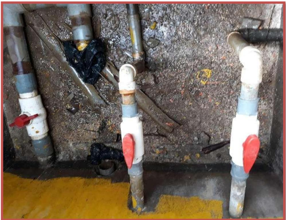
*Imagen 07.* Accesorios de la caseta de válvulas del reservorio
