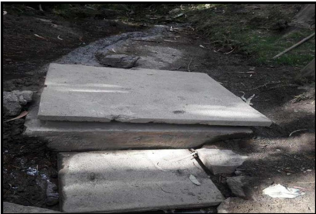
*Imagen 18.* Captación Pisca (protección de afloramiento, cámara húmeda y seca deterioradas)
