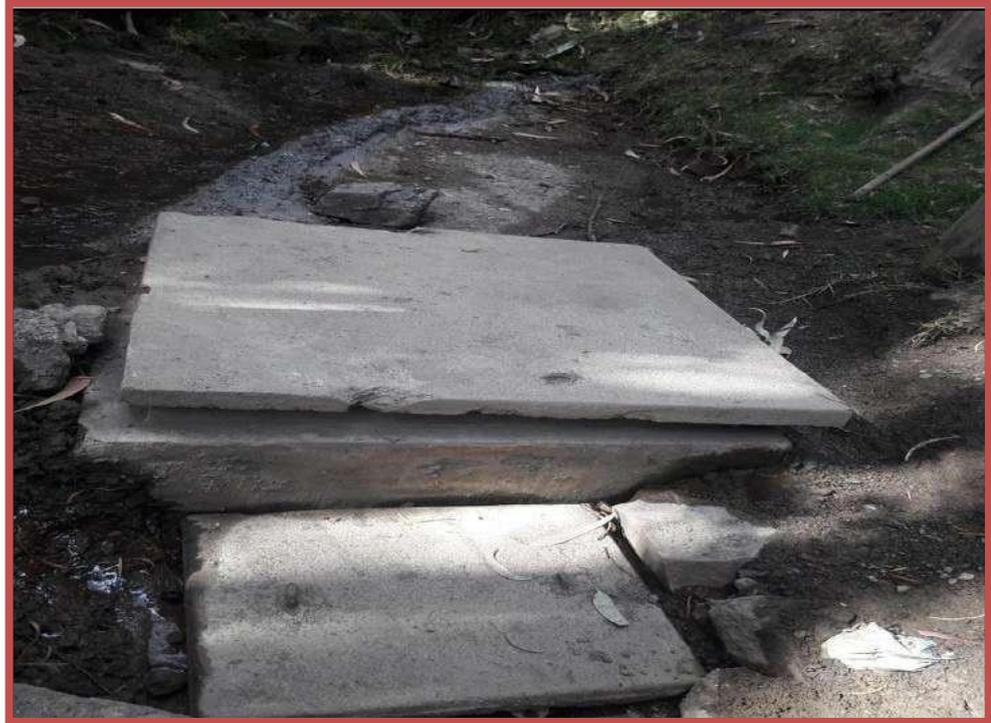
**Imagen 01.** La protección de afloramiento de la captación está en mal estado y en la cámara húmeda no cuenta con aletas.
